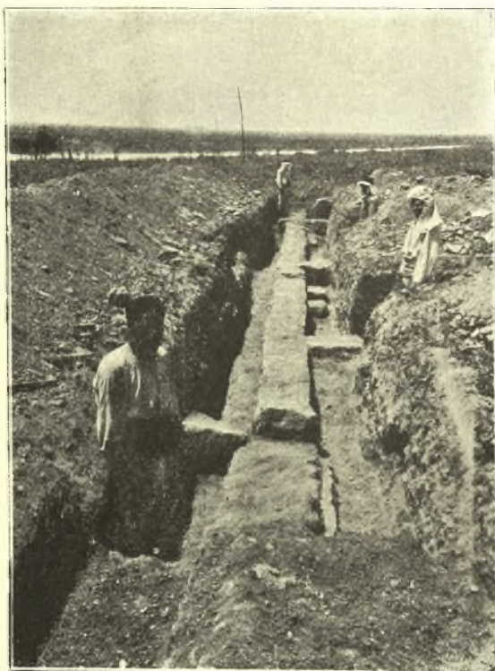
Εἰκ. 11. Ἀποψις νοτίου τοίχου οἰκοδομῆ Δ.
