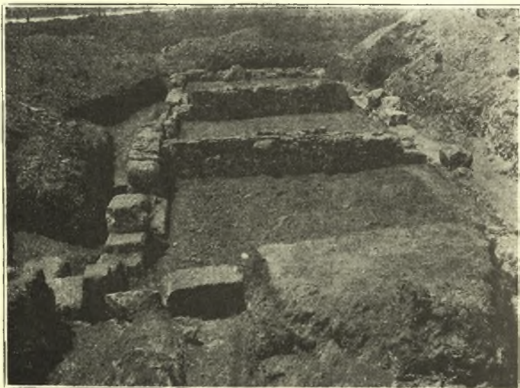
Εἰκ. 5. Οἰκοδόμημα Β ἀπ' Ἀνατολῶν.
