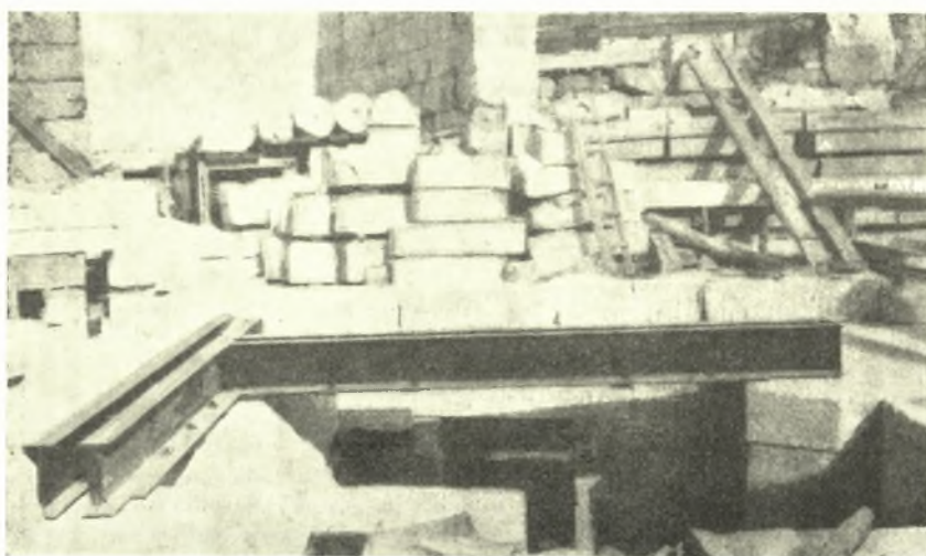
Εἰκ. 29. Τοποθέτησις ζεύγους σιδηροδοκῶν πρὸς ὑποστήριξιν τῆς ΒΑ γωνίας τοῦ ναοῦ.
