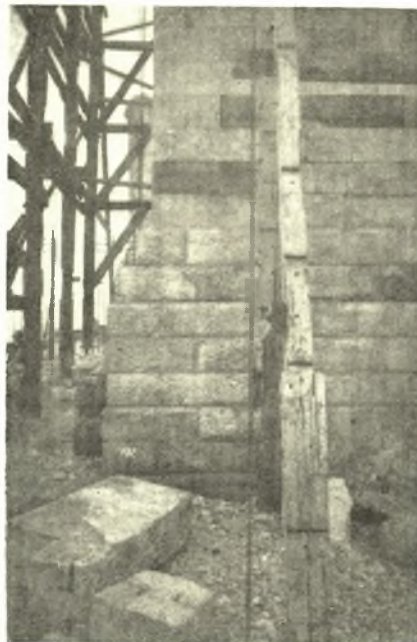
Εἰκ. 27. Ἡ ΝΔ γωνία τοῦ ἀνακατασκευασθέντος περιβλήματος.
