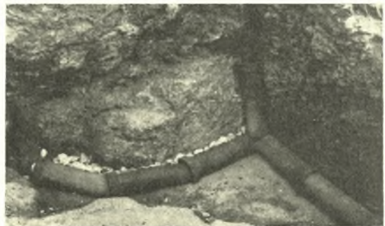
Εἰκ. 26. Τοποθέτησις ἡμισωλήνων πρὸς ἀποστράγγισιν τῶν ἐκ τῶν βράχων ὑδάτων.
