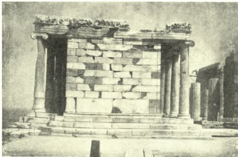
Εικ. 1. Ἡ πρὸ μεσημβριάν ἀποψις τοῦ ναοῦ ἐν ἧ ἐμφαίνεται ἡ καθίζησις τοῦ κρηπιδώματος.
