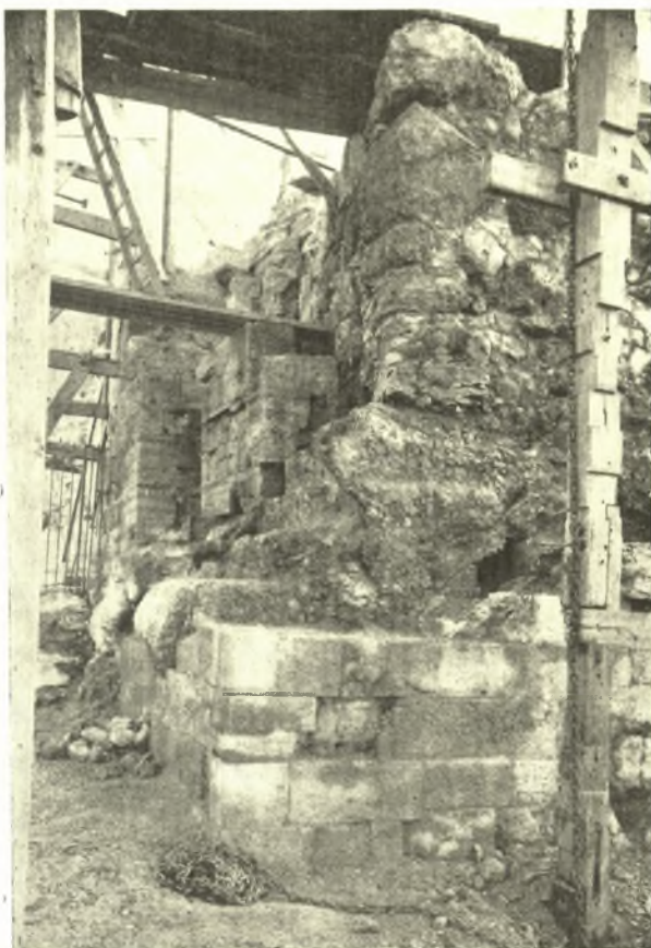
Εἰκ. 18. Ἀποψις τῆς ΝΔ γωνίας τοῦ Πελασγικοῦ τείχους, εἰς ἣν ἐμφαίνονται οἱ ἐπὶ τοῦ βράχου λαξευτοὶ ἀναβαθμοὶ πρὸς ἔδρασιν τῶν σχετικῶν δόμων τοῦ περιβλήματος ὡς καὶ οἱ τοποθετηθέντες κατὰ τὸ 1901 λίθοι πρὸς στερέωσιν τῆς βάσεως τῆς ΝΔ γωνίας τοῦ περιβλήματος.
