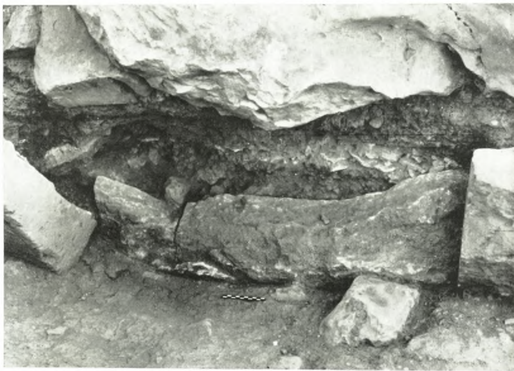
Εἰκ. 68. Στρῶμα λατύπης κάτωθεν τοῦ θεμελίου τοῦ ἀναλημματικοῦ τοίχου τῆς ἐπικλινούσ ἀναβάσεως (Ramp).
