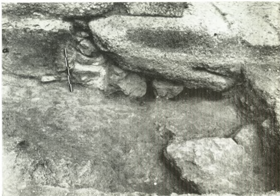
α. Ἡ ὑποθεμελίωσις τοῦ ἄνατολικοῦ ἄκρου τοῦ κατωφλίου τῆς πύλης τῶν λεόντων.
