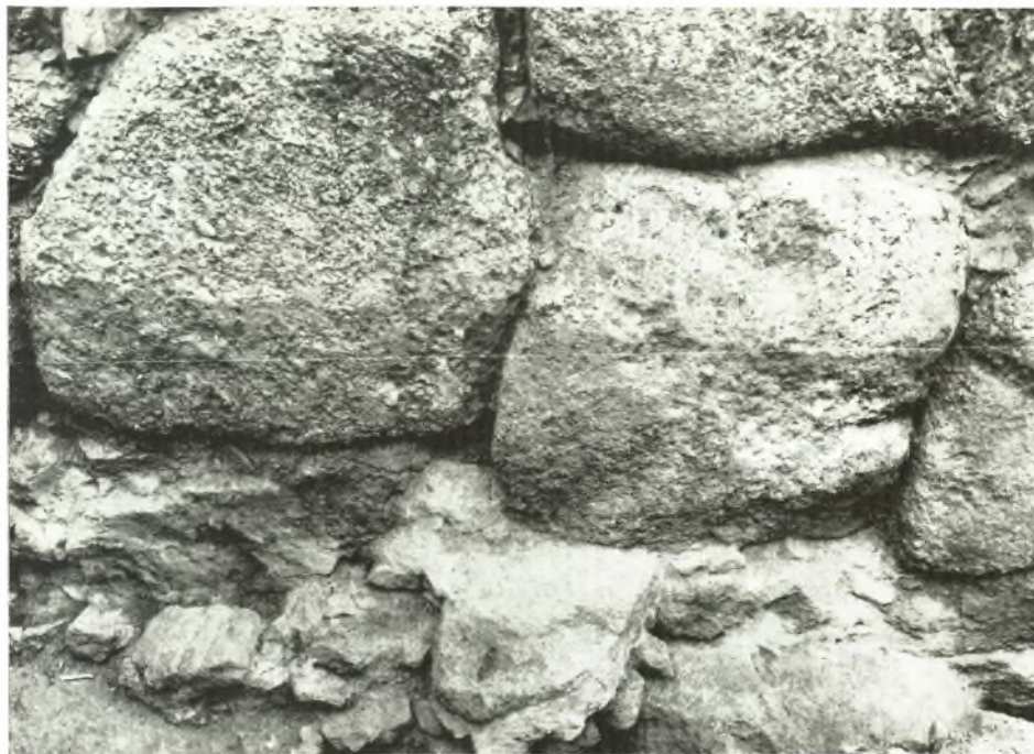
α. Λεπτομέρεια τῆς ὑποθεμελίωσης τῆς ἀνατολικῆς πλευρᾶς τοῦ πύργου τῆς πύλης τῶν λεόντων.
