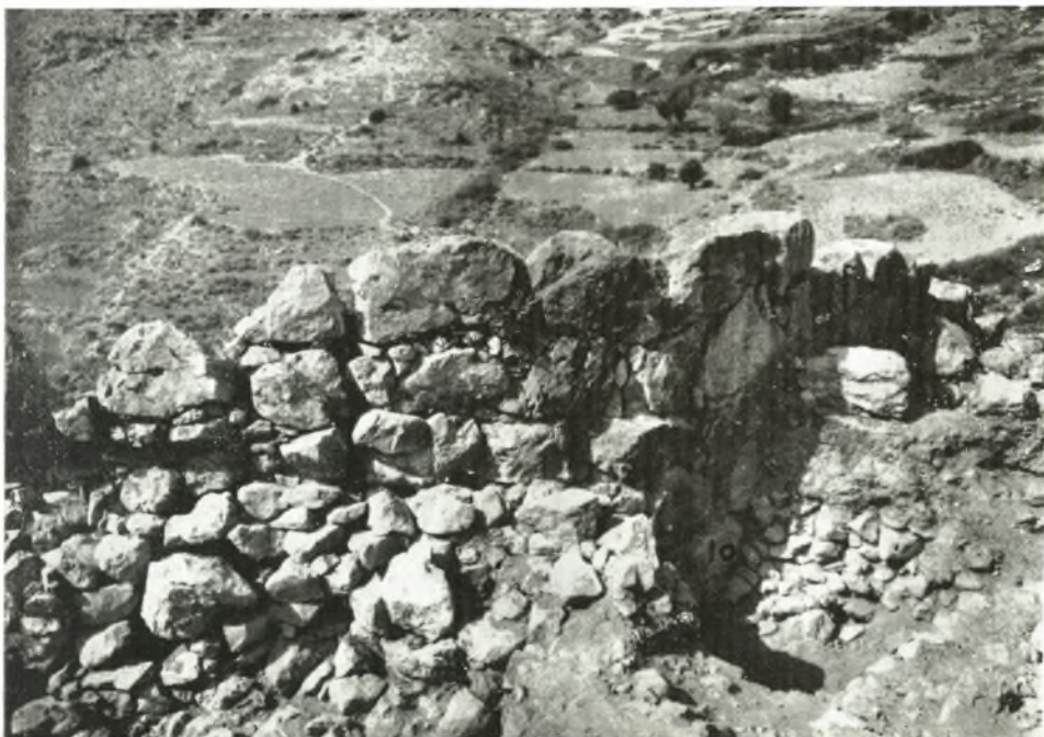
β. Ἐφ. 10: ἡ ἀρχὴ τοῦ βορείου σκέλους τῆς βορειοανατολικῆς ἐπεκτάσεως Ἀριστερᾶ, τὸ διασκευασθὲν τμήμα τῆς ἐσωτερικῆς ὄψεως τοῦ βορείου κυκλωπέιου τείχους.
