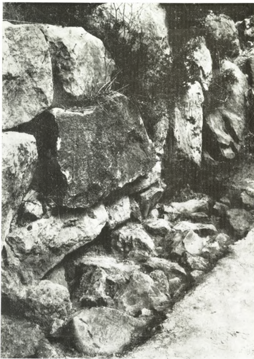
Εἰκ. 6. Ἡ ὑποθεμελίωσις τῆς ἐσωτερικῆς ὄψεως τοῦ βορείου τεύχους κατὰ τὰ 15 μ. μήκους.
