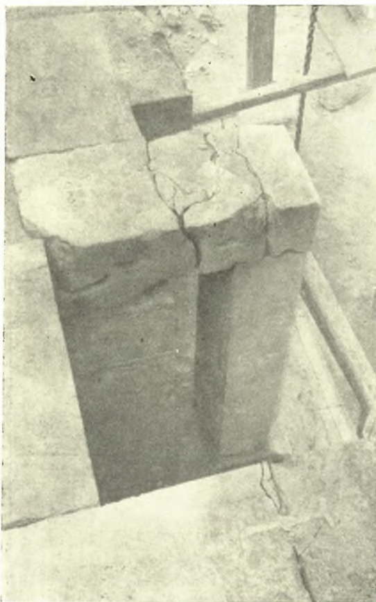
Εἰκ. 19. Τὸ ἐπίκρανον κατεστραμμένον τοῦ διαμέσου κιονίσκου. Οὗτος δὲν ἐφάπτεται τοῦ ὀπισθεν τοίχου.
