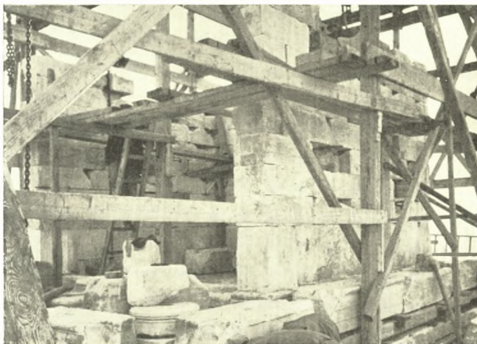
Εἰκ. 33. Δοκιμαστικὴ ἀναστήλωσις τοίχων σηκοῦ. (Φωτογρ. Τ. Βόγλη).
