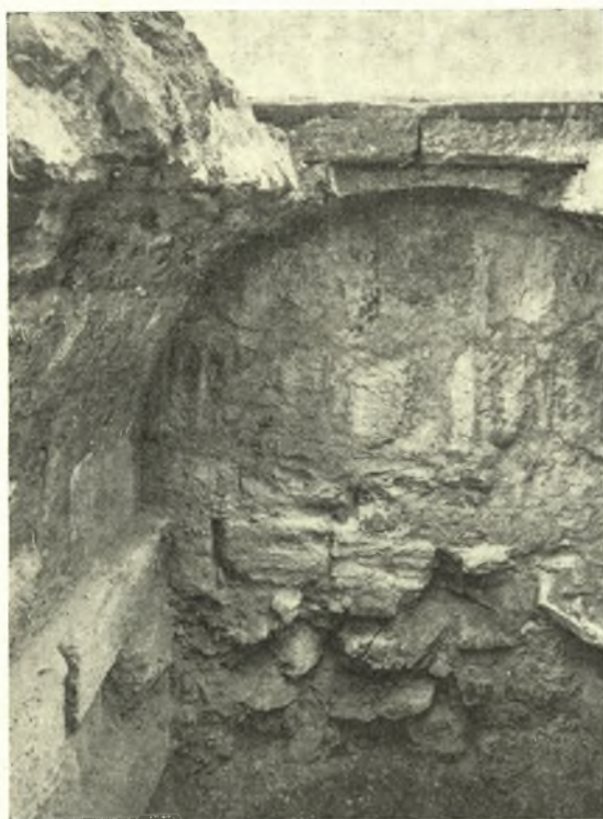
Εἰκ. 4. Ἀποψὶς τοῦ θόλου τῆς Τουρκικῆς κρύπτης, ἧς ὁ πυθμὴν ἐξικνεῖται μέχρι τῆς γενέσεως τοῦ θόλου, κάτωθεν ριπτὰ χώματα καὶ ὀγκόλιθοι. (φωτ. Ἰταλικῆς Ἀρχ. Σχολῆς).
