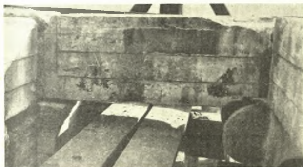
Εἰκ. 6. Τὸ γωνιαῖον πρὸς δυσμὰς ἐπιστύλιον τῆς μεσημβρινῆς πλευρᾶς, λαξευθὲν κατὰ τὴν ΝΔ γωνίαν αὐτοῦ, ὅπως ἰσοφαρίσῃ τὴν διαφορὰν τοῦ ὕψους τῶν βάσεων τῆς παραστάδος καὶ τοῦ γωνιαίου κίονος. Ἡ ἄλλη γωνία τοῦ αὐτοῦ ἐπιστυλίου δὲν προσηρμόζετο εἰς τὸ τοῦ σηκοῦ.
