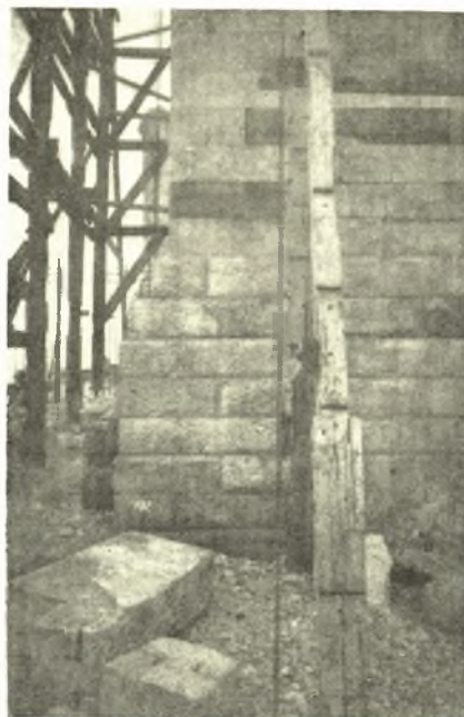
Εἰκ. 27. Ἡ ΝΔ γωνία τοῦ ἀνακατασκευασθέντος περιβλήματος.
