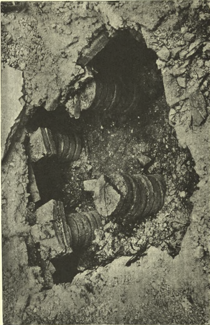
Είχ. 10. Ὑπόγειον κατασκευάσµα ἐκ πλινθίνων κιονίσκων χρησιµεῖον ὡς « Ὑπόκαυστον » ἐπὶ τὴν ἀνατολικὴν μεγάλην αἴθουσαν τοῦ « Περιστυλίου » ἐν Νικοπόλει.
