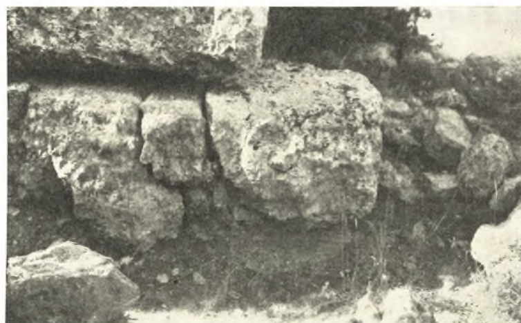
Εἰκ. 2. Τμήμα βορείου τείχους τῆς Γαληψοῦ. Λεπτομέρεια θεμελιώσεως.
