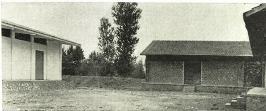
Μερικὴ ἄποψις ἀποθηκευτικῶν συγκροτημάτων προτύπου Γ.Π. Συνεταιρισμοῦ Παραποτάμου Σγαρίου - Τρικάλων
