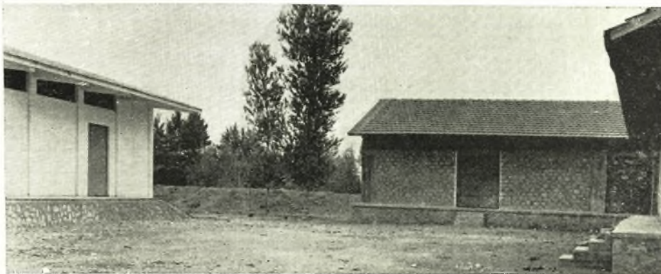
Μερικὴ ἄποψις ἀποθηκευτικῶν συγκροτημάτων προτύπου Γ.Π. Συνεταιρισμοῦ Παραποτάμου Σγαρίου - Τρικάλων
