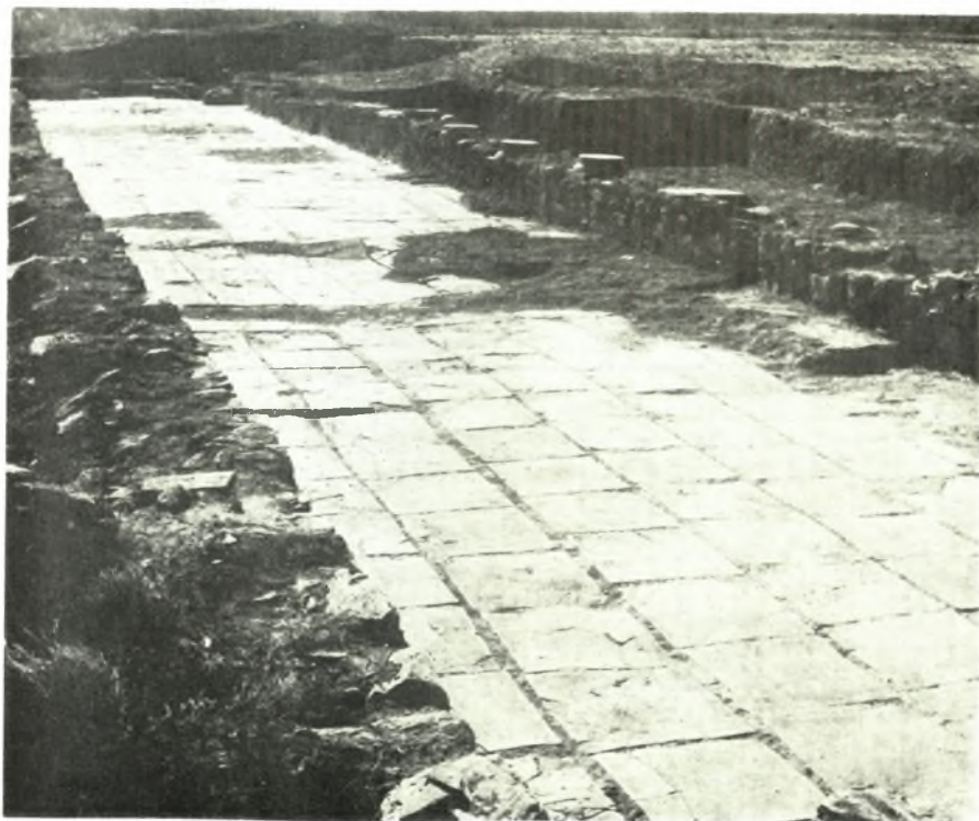
Νέα Ἄγχιαλος: α. Τοιχοποιία β' περιόδου. β. Πλακόστρωσις Ν. Στοῦς
