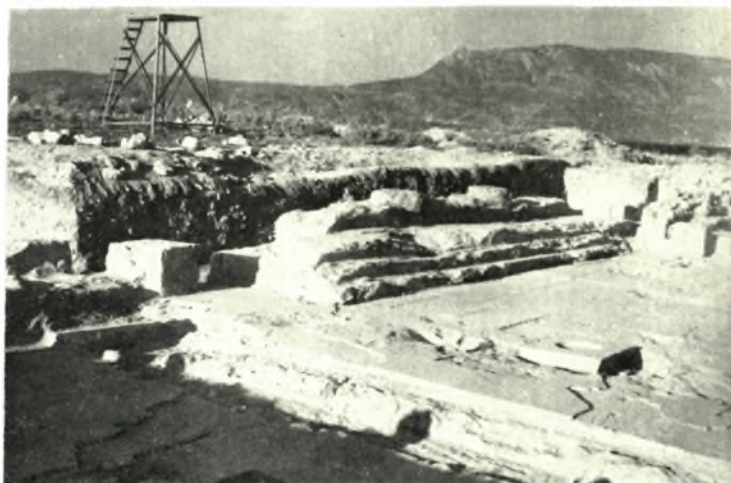
Λέχαιον: α. Βασιλική. Ἐποψὶς τοῦ βήματος ἐκ Δ. (μετὰ τὴν ἀφαίρεσιν τῶν μεταγενεστέρων τοίχων), β. Ἄμβων (ἐκ Ν.), γ. Βόρεια ἔδρανα βήματος (ἐκ ΝΔ.)
