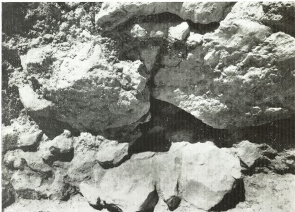
Εἰκ. 64. Τριγωνικὸς χώρος εἰς τὸν κατώτατον δόμον τοῦ δυτικοῦ κυκλώπειου τείχους.
