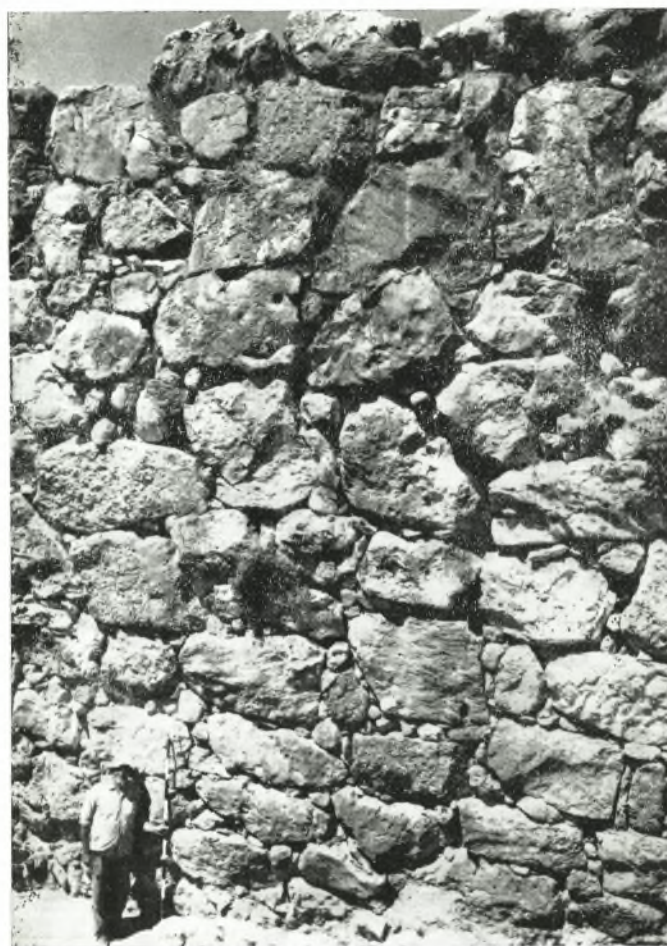
Εἰκ. 63. Ἐσωτερικὴ ὄψις τοῦ δυτικοῦ κυκλωπείου τείχους. Ὑψος ἀπὸ τοῦ βράχου 8.25 μ.
