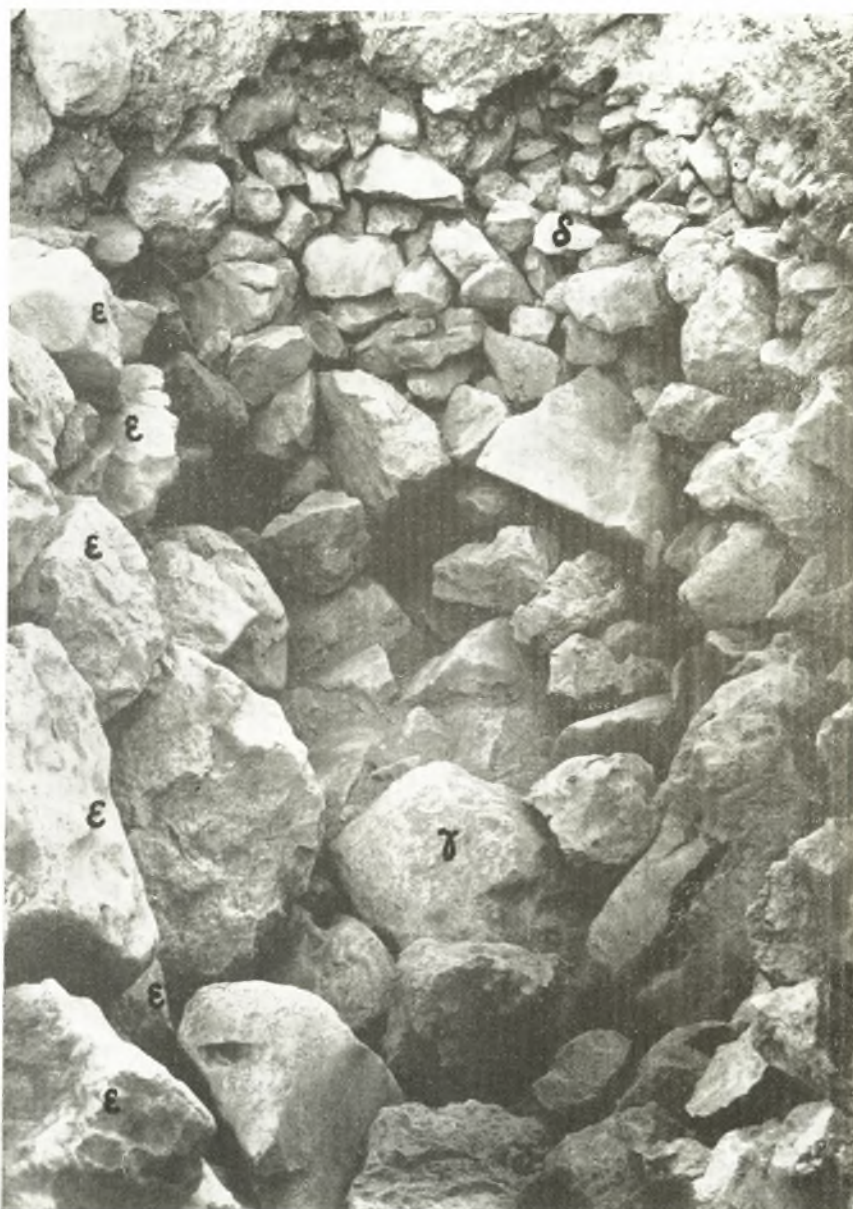
Εἰκ. S. Νότιον κυκλώπειον τείχος, ε-ε-ε: ἐσωτερικὴ τοῦ ὄψις, γ: γέμισμα τοῦ μυκηναϊκοῦ πυρῆνος, δ: γέμισμα τῶν ἐλληνιστικῶν χρόνων.
