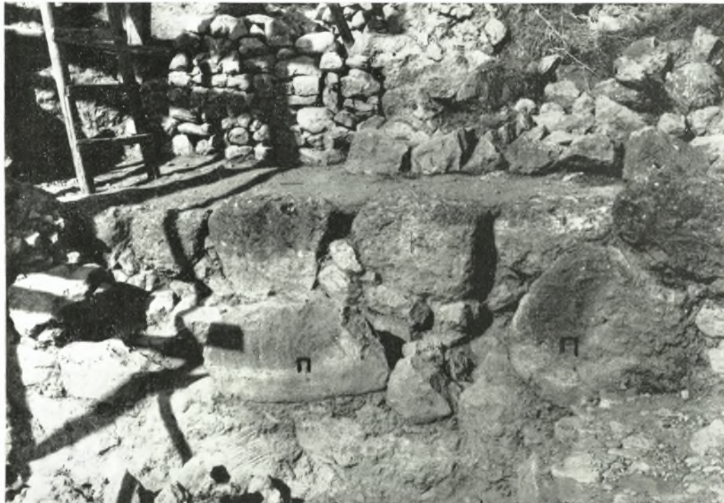
Εἰκ. 83. Σειρὰ κροκαλοπαγῶν λίθων (Κ) ὀπισθεν τοῦ πλευρικοῦ τοίχου (II - II) τῆς ἐπικλινοῦς ἀναβάσεως.
