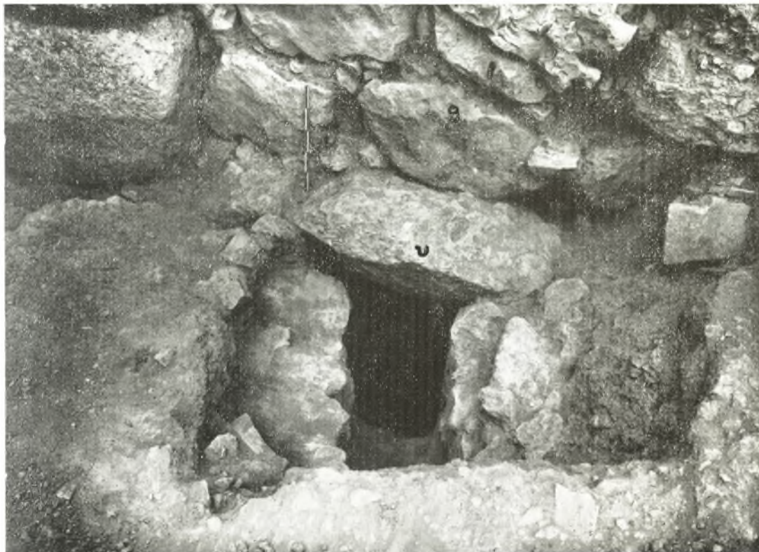
Εἰκ. 57. Ὁ ὑπὸ τὸ θεμέλιον τοῦ τοίχου Θ ὑπόνομος «υ».
