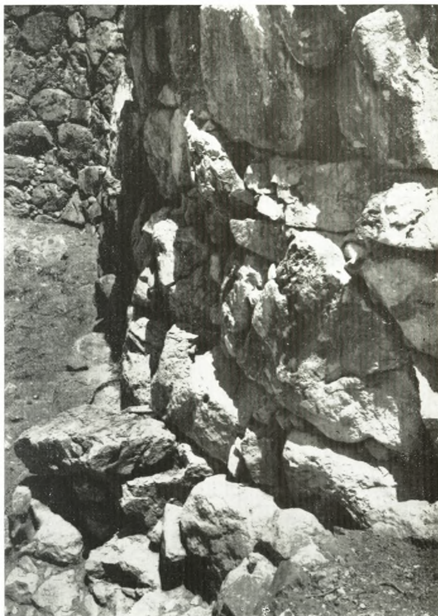
Εἰκ. 90. Ἡ νοτιοανατολική γωνία τοῦ τοίχου τῆς ἐπεκτάσεως.
