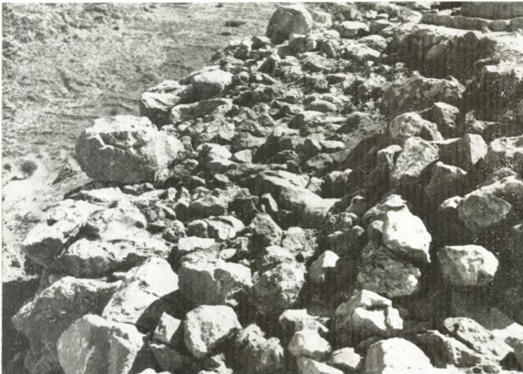
Εἰκ. 100. Γέμισμα λίθων ὑποβασταζόμενον ὑπὸ τοῦ ἀναλημματικοῦ τοίχου Α τῆς εἰκόνας 99.
