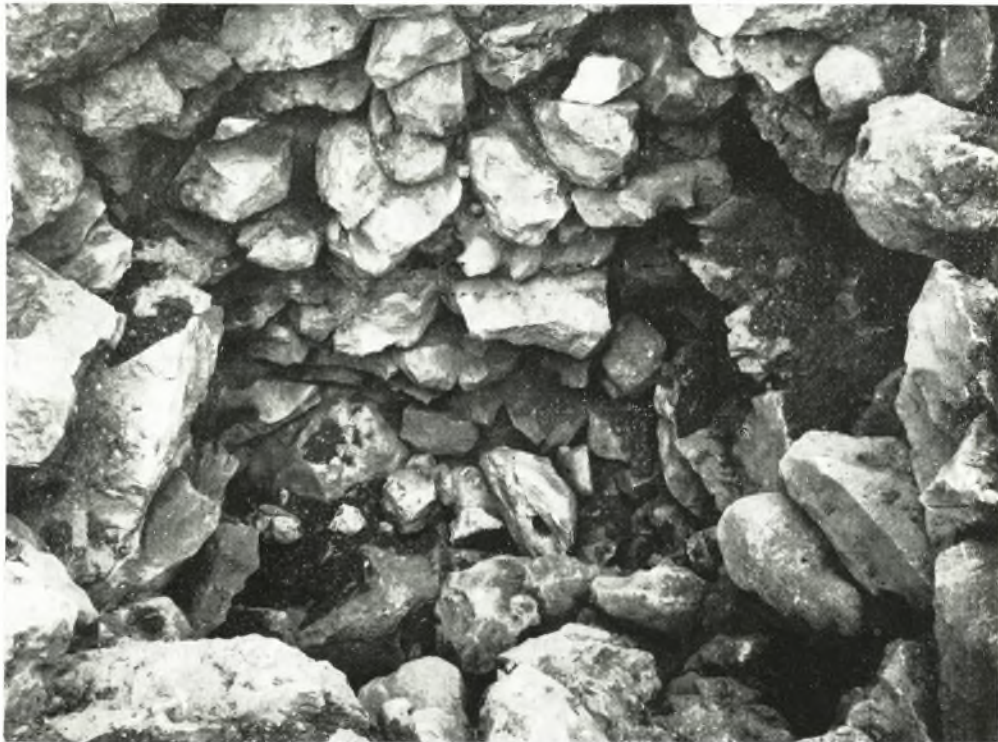
Εἰκ. 89 Τομὴ εἰς τὸν πυρῆνα τοῦ νοτίου τείχους τῆς νοτιοανατολικῆς ἐπεκτάσεως.
