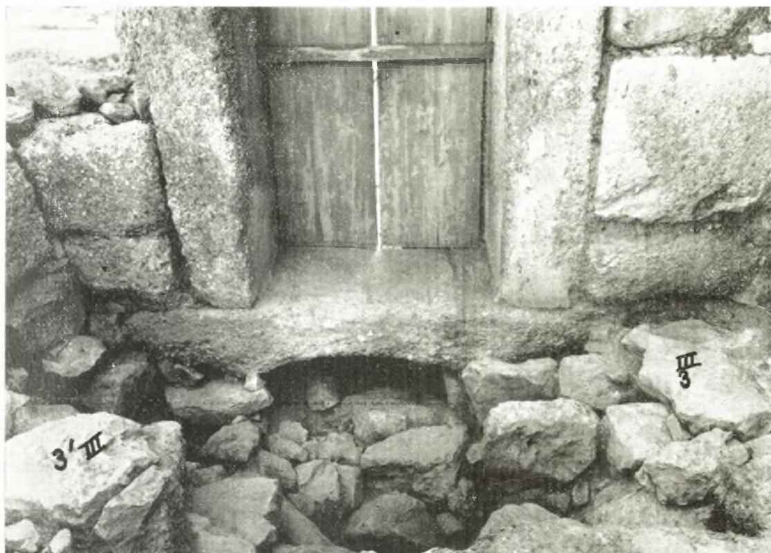
Εἰκ. 21. Ἐσωτερικὴ πρόσοψις τῆς β ο ρ ε ί ας πύ λ ης. Ἡ πρὸ τοῦ κατωφλίου περιοχὴ. III-3 χ ο α ν ο ι ε ἰ δ ῆς ὀ π ῆ ὑ π ο ν ὄ μ ο υ. III-3' φ ρ ε ά τ ἰ ο ν τοῦ ὑ π ο ν ὄ μ ο υ.
