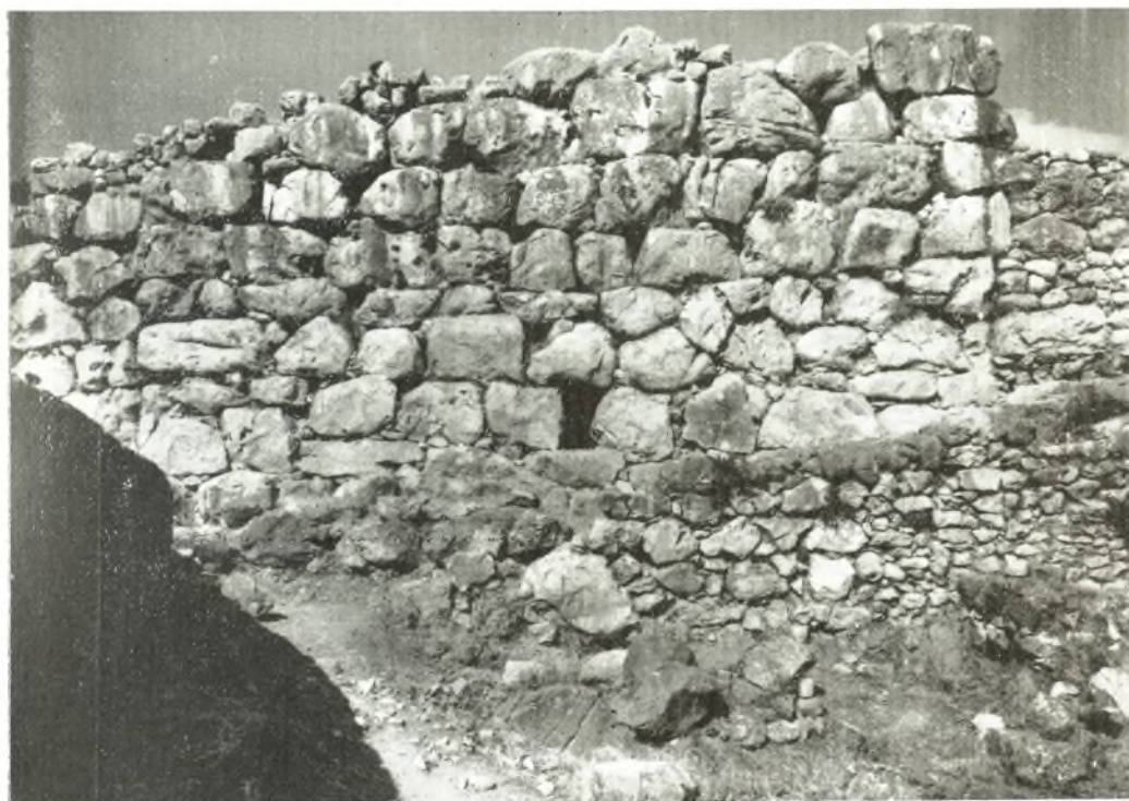
Εἰκ. 75. Τὸ στόμιον τοῦ ὑπονόμου τοῦ ἀναλημματικοῦ τοίχου. Τὸ σκοτεινὸν τμῆμα εἶναι πλάκες περιφερείας τοῦ κύκλου Α.
