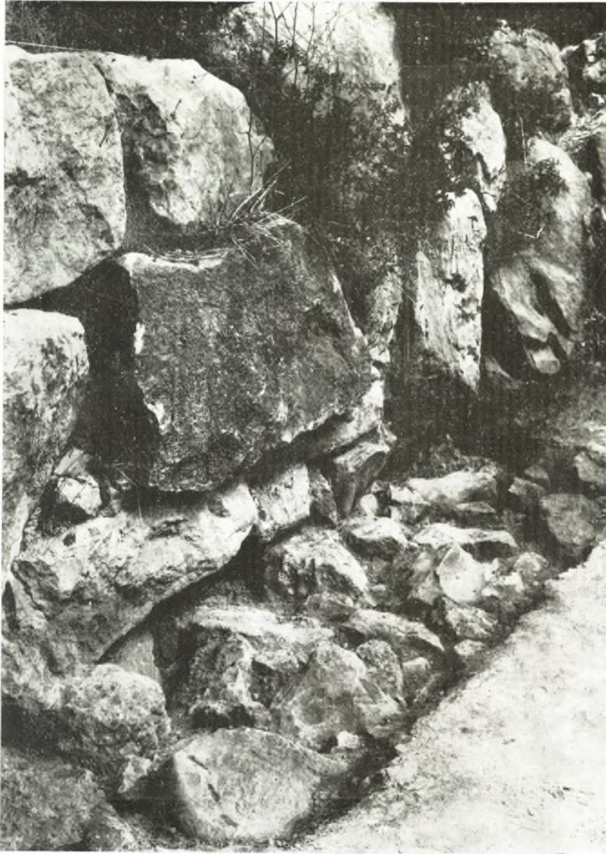
Εἰκ. 6. Ἡ ὑποθεμελίωσις τῆς ἐσωτερικῆς ὄψεως τοῦ βορείου τεῖχους κατὰ τὰ 15 μ. μήκους.
