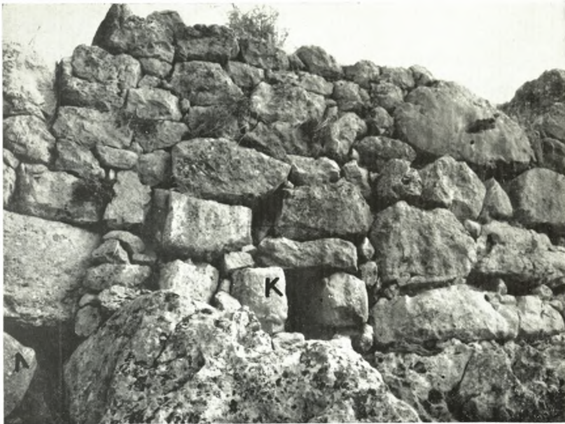
Εἰκ. 14. Τμήμα τείχους μεταξύ τοῦ προμαχῶνος καὶ τοῦ βορείου κυκλωπείου τείχους. Κ, Α, στόμια ὑπνόμων.
