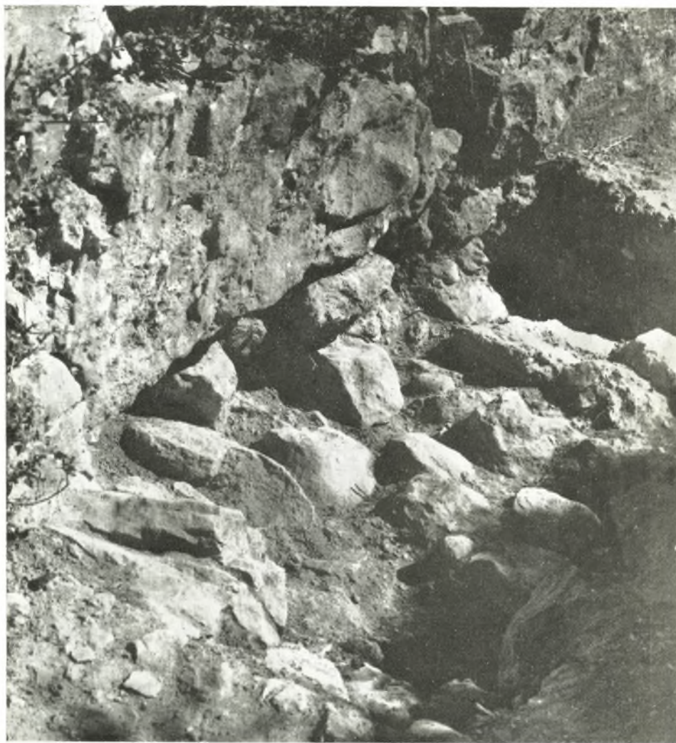
Εἰκ. 7. Ἡ ὑποθεμελίωσις τῆς ἐσωτερικῆς ὄψεως τοῦ βορείου τεύχους κατὰ τὰ 20.50 μ. μήκους.
