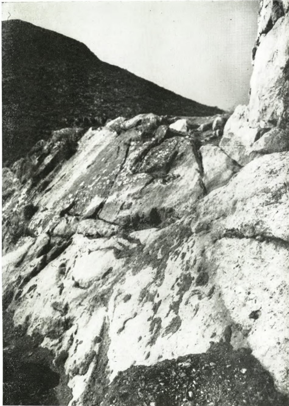
Εἰκ. 96. Ἡ διαμόρφωσις τῶν βράχων κατὰ τὴν ἀνατολικὴν καμπὴν τοῦ περιβόλου τῆς ἐπεκτάσεως.
