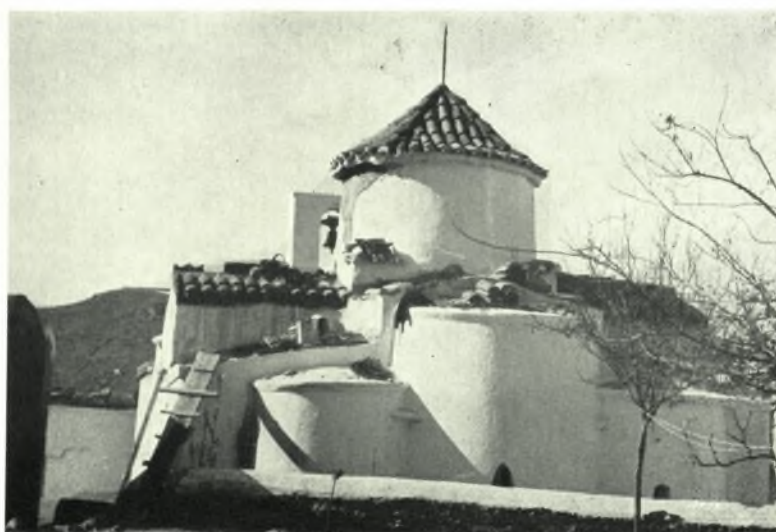
Σέριφος. Παναγιά. Ναός της Θεοτόκου: α. Ό ναός από της ΒΔ. γωνίας, β. Θωράκιον, γ. Ή ανατολική πλευρά του ναού κατά την διάρκεια των έργων ανάκεραμώσεως
