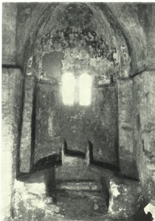
Νάξος. Ναός Δροσιανῆς: α - β. Τὸ ἀνατολικὸν παρεκκλήσιον καὶ ἡ ἄψις αὐτοῦ μετὰ τὰς στερεωτικὰς ἐργασίας
