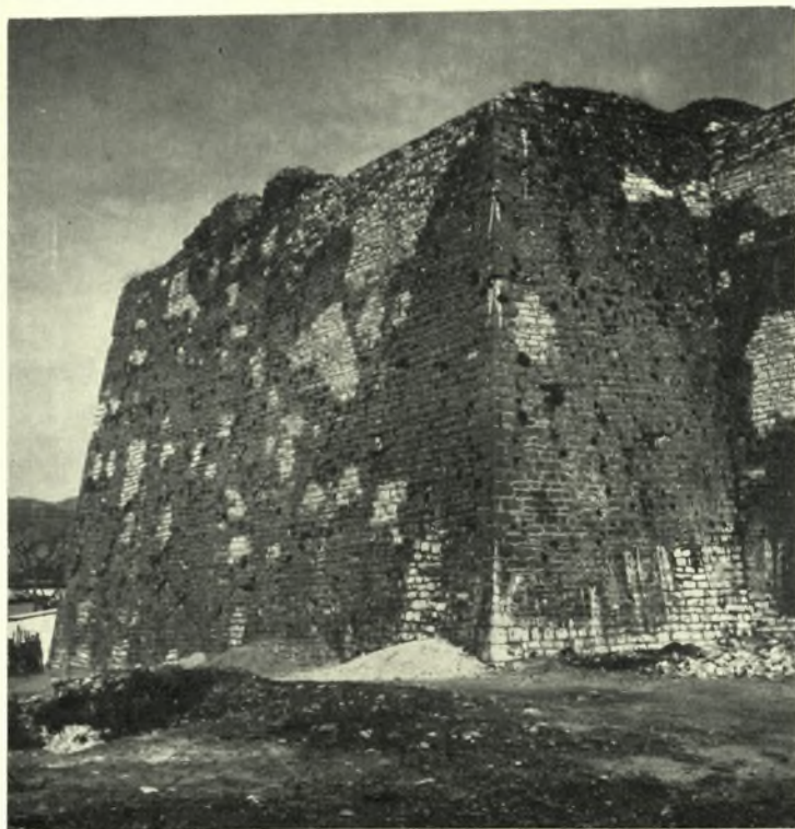
Ἡπειρος. Κάστρον Ἰωαννίνων: α - β. Τμήμα τοῦ ἐσωτερικοῦ περιβόλου πρὸ καὶ μετὰ τὰς ἐργασίας στερεώσεως
