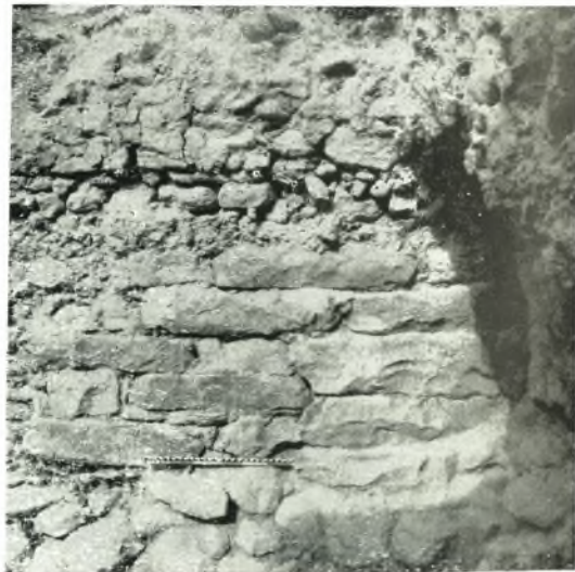
4 – Lastre calcaree del 1 periodo riadoperate in un muro del 3 periodo (pag. 119).
