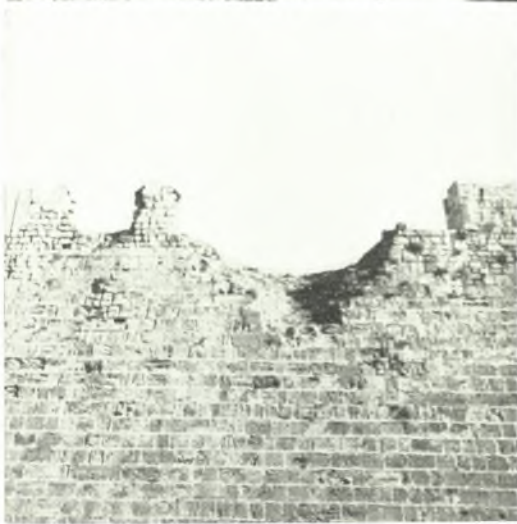
Ρόδος : α. Έπισκευή τοίχου κατά τὸ ἐσωτερικὸν τῆς πύλης D'Amboise, β-γ. Δευτέρα ἐπαλξις ἀπὸ τοῦ προμαχώνος τοῦ Ἁγίου Γεωργίου πρὸς Β. πρὸ καὶ μετὰ τὰς ἐργασίας, δ. Ἡ ἐνάτη καὶ δεκάτη ἐπαλξις ἀπὸ τῆς πύλης D'Amboise μετὰ τὴν ἐπισκευὴν, ε-ζ'. Ἡ ἕκτη καὶ ἑβδόμη ἐπαλξις ἀπὸ τῆς πύλης D'Amboise πρὸ καὶ μετὰ τὰς ἐργασίας
