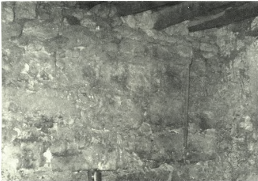
Κρήτη. Ἄρχαναι : α. Ὁ ἄγωγός με τοὺς ἀναλημματικούς αὐτοῦ τοίχους ἀπὸ Ν., β. Θεμελίωσις τοῦ κύκλου, γ. Μινωϊκὸς τοῖχος εἰς ἰσόγειον οἰκίας
