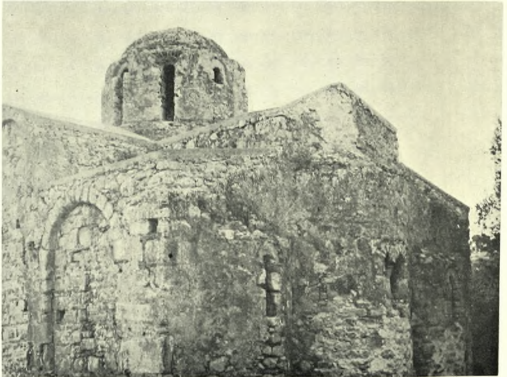
Κρήτη. Στύλος Ἀποκορώνου. Ναός Παναγίας: α. Νοτιοδυτική ὄψις πρὸ τῶν ἐργασιῶν ἀναστηλώσεως, β. Νοτιοανατολική ὄψις μετὰ τὰς ἐργασίας ἀναστηλώσεως
