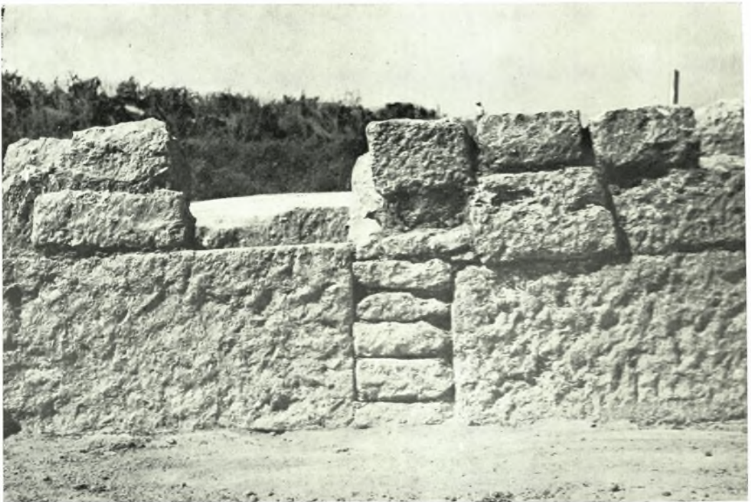
Πέλλα. Τομείς VI: α. Όχετός μετά κορινθιακών στρωτήρων, β. Τοιχοδομία του δωματίου Δ (της δεύτερας περιόδου)
