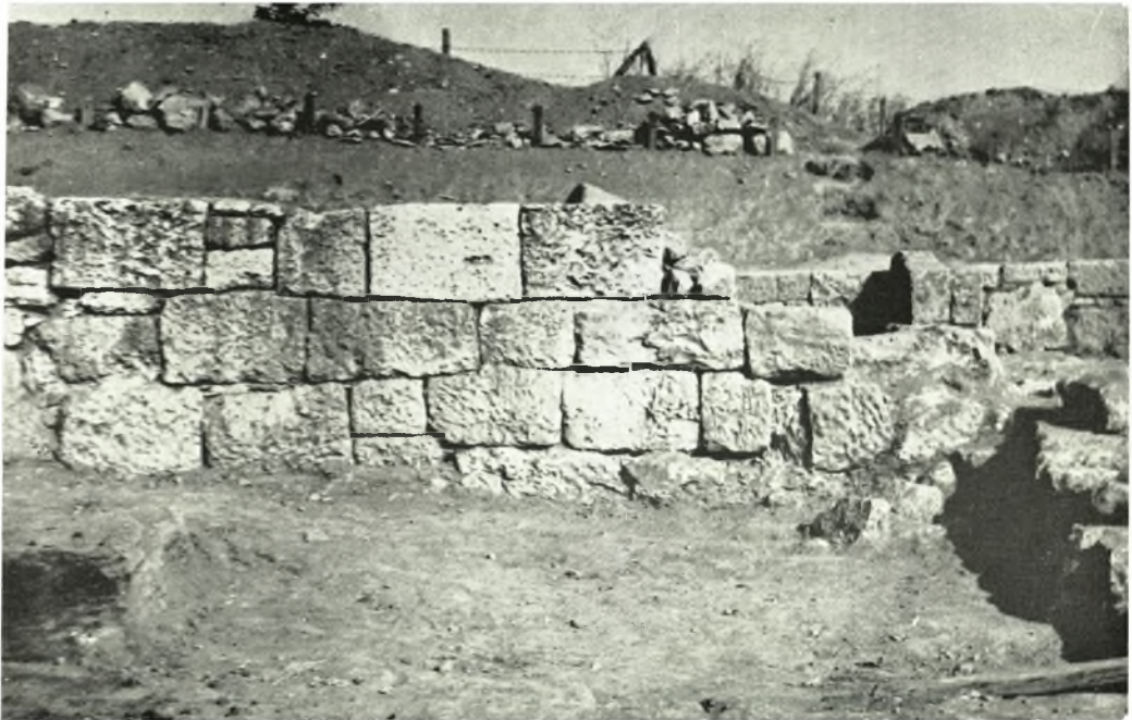
Πέλλα. Τομείς Ι, τετράγωνον 2: α. Βορειοανατολική περιοχή, β. Τοιχοδομία του μεταξύ των δωματίων Μ και Ν μεσοτοιχίου. Όψις από δυσμών
