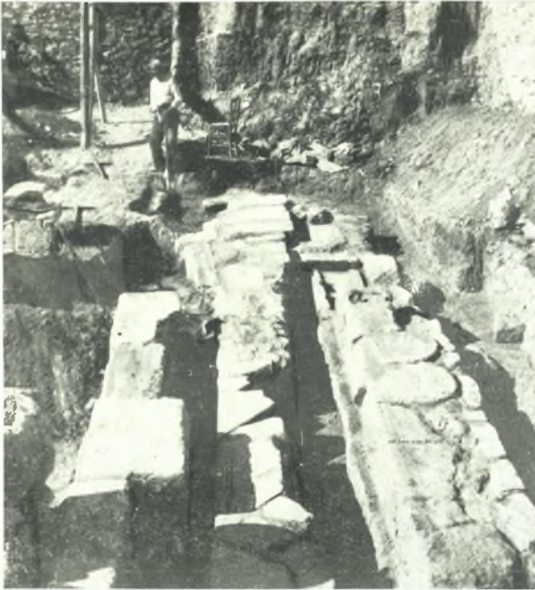
α. Τὰ ἐν τῷ μέσῳ τοῦ οἰκοπέδου ἀποκαλυφθέντα θεμέλια μέ τὸ πλακόστρωτον μεταξὺ αὐτῶν.
