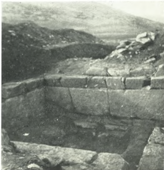
β. Τὸ ταφικὸν κτίσμα μετὰ τῶν ἀποκατασταθέντων λίθων κατὰ τὴν βάσιν τῆς στέγης.
