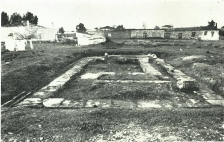
β. Θεμέλια κρηναίου πιθανῶς οἰκοδομήματος.
