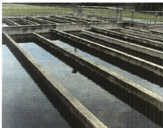
Εικόνα 2.3.5.1. Δεξαμενές απολύμανσης (Ράμμος, 2006).
