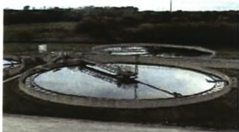
Εικόνα 2.3.2.1. Δεξαμενές καθιζήσεως (Ράμμος, 2006)
