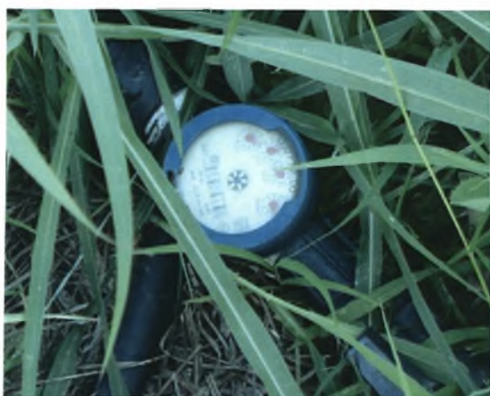
Εικόνες 4.5.5 και 4.5.6. Υδρόμετρο καθαρού νερού (αριστερά) και υδρόμετρο λύματος (δεξιά).
