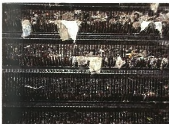
Εικόνα 2.3.1.1. Σχάρες συγκράτησης στερεών αντικειμένων (Ράμμος, 2006).
