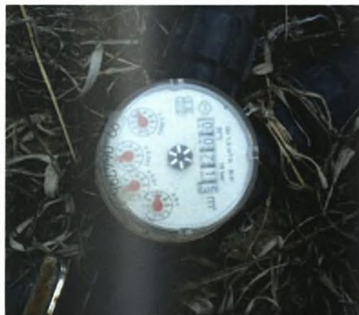
Εικόνες 4.5.5 και 4.5.6. Υδρόμετρο καθαρού νερού (αριστερά) και υδρόμετρο λύματος (δεξιά).
