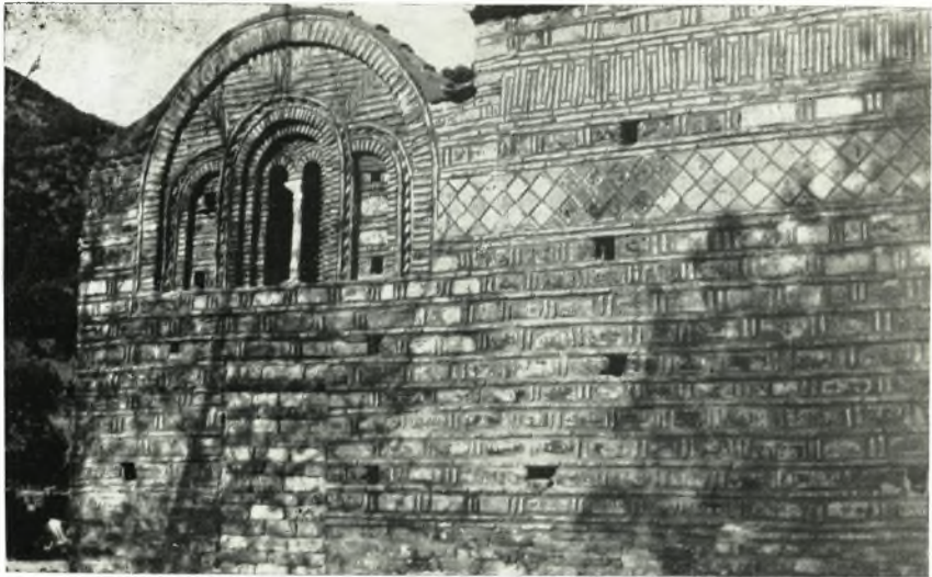
β. Ἀποψις τῆς πλαγίας πλευρᾶς τῆς Παναγίας Βελλᾶς μετὰ τὰς ἐργασίας ἀποκαταστάσεως τῆς ζατρικοειδοῦς ζωφόρου.
