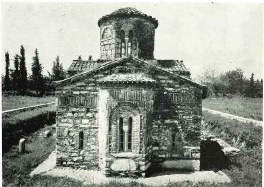
β. Ἡ ἀνατολική πλευρά τοῦ Ἁγ. Νικολάου τῆς Ροδιάς μετὰ τὰς ἐργασίας ἀναστήλωσεως.
