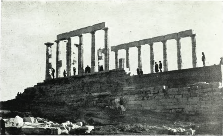
α. Ὁ ἐν Σουνίῳ ναὸς τοῦ Ποσειδῶνος μετὰ τὴν ἀναστήλωσιν τοῦ βου βορείου κίονος.
