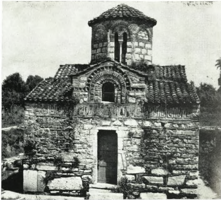
α. Ἡ δυτική πλευρά τοῦ Ἁγ. Νικολάου τῆς Ροδιάς μετὰ τὰς ἐργασίας ἀναστήλωσεως.
