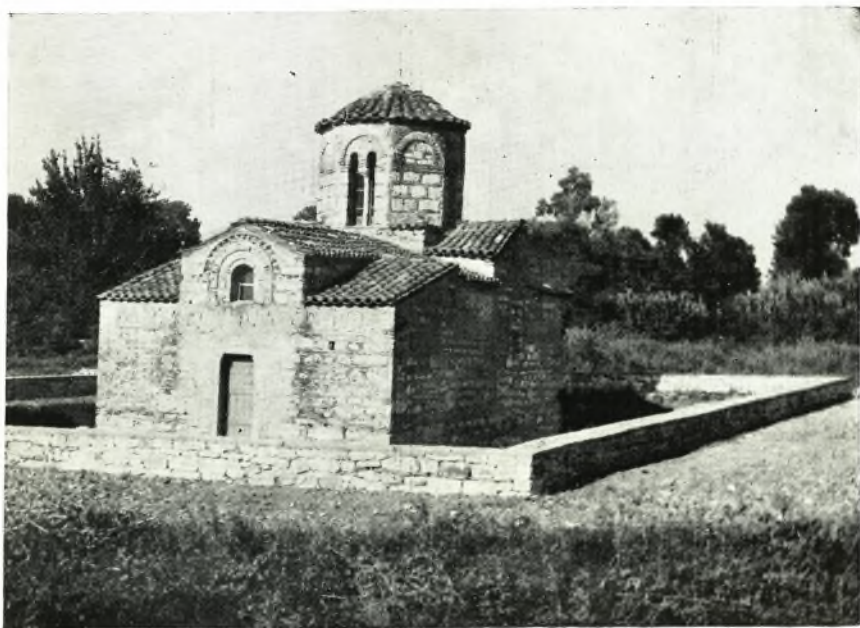
β. Ὁ Ἅγ. Νικόλαος τῆς Ροδιᾶς μετὰ τὰς ἐργασίας ἀναστηλώσεως. Ὅψις ἀπὸ ΝΔ.
