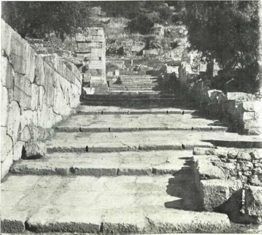
β. Ἡ ἱερὰ πομπικὴ ὁδὸς μετὰ τὰς ἐργασίας τακτοποιήσεως αὐτῆς ὑπὸ τῆς Ὑπηρεσίας Ἀναστηλώσεως.
