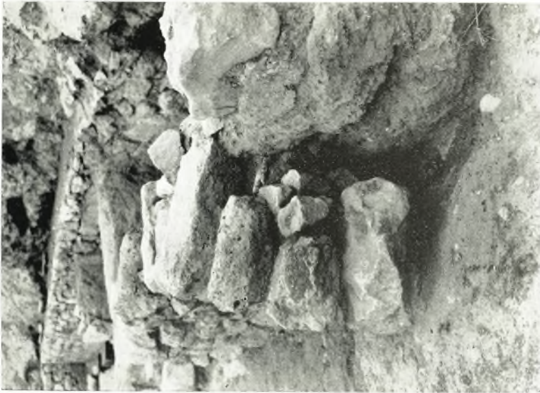
β. 'Η Β.Α. εξωτερική γωνία τοῦ τετάρτου δοματίου τῆς Οικίας μὲ τὰ κωνίσια ὑπέρθεον (εἰς τὴν εἰκόνα δεξιὰ) τῆς ἐξωτερικῆς σειρᾶς τῶν λίθων.
