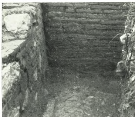
α. Ύψωτερική ὄψις μέρους τοῦ πλινθοκτίστου νοτίου τοίχου (νοτιοανατολική γωνία τῆς αἰθούσης Α) (ἀπὸ Β.).
