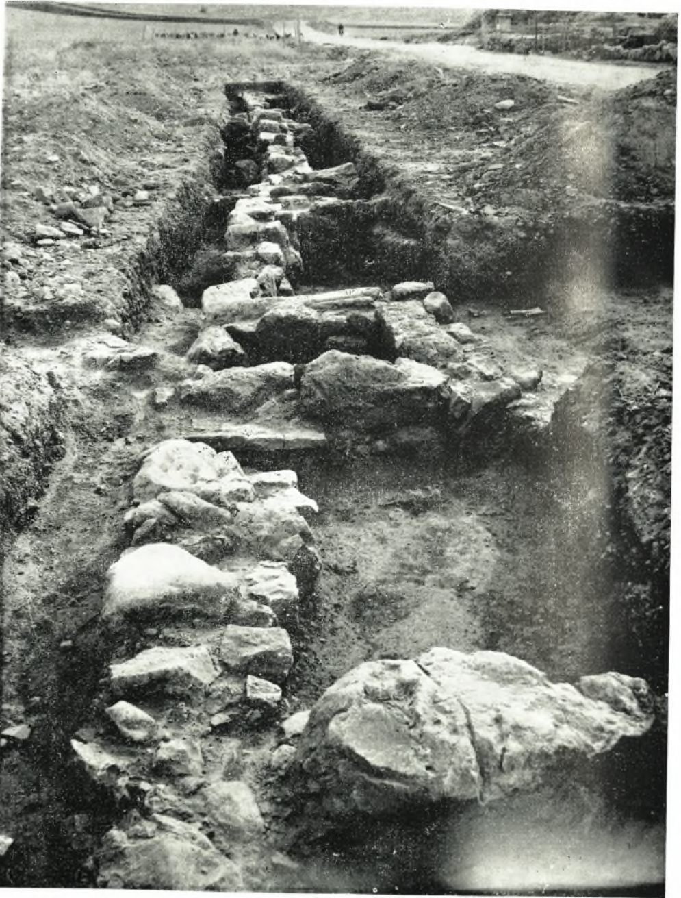
Τὰ πρὸς Β. τῆς κρήνης καὶ παρὰ τὸν καταχωσθέντα μυχὸν τοῦ λιμένος Μικρὸ Βαθὺ ἀποκαλυφθέντα κτίσματα.
