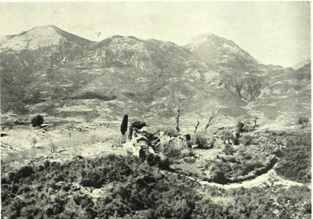
Εύρωτασία: α-β. Ἡ Μονή Τατάρνας πρὸ καὶ μετὰ τὴν καταστροφὴν
