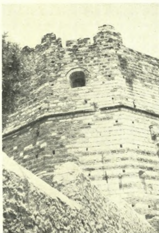
Ἀχαΐα. Φρούριον Πατρῶν: α - β. Ὅψεις τοῦ πολυγωνικοῦ πύργου τῆς ἀνατολικῆς πλευρᾶς πρὸ καὶ μετὰ τὴν στερέωσιν
