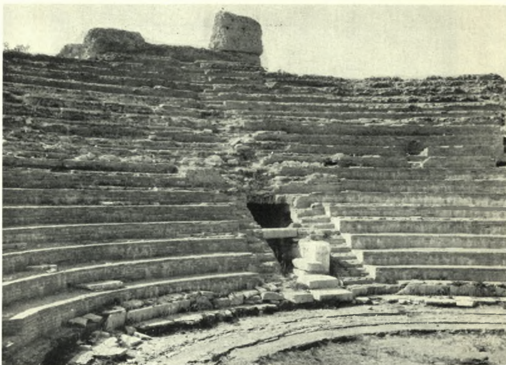
*Ηπειρος. Νικόπολις: α. Τὸ ἐξ ἀκανονίστως τοποθετημένων πλινθῶν ὑπόστρωμα τῶν ψηφιδωτῶν τῆς βασιλικῆς Β (Ἰαλκίσωνος), β. Τὸ κοίλον τοῦ Ὁδείου τῆς Νικοπόλεως μετὰ τὰς ἐργασίας συμπληρώσεως τῶν ἐδωλίων του
