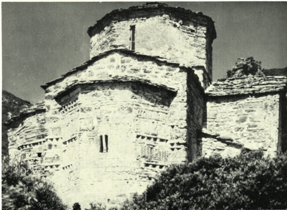
Ἄχαϊα. Δραγάνον: α - β. Ὁ βυζαντινὸς ναὸς τοῦ Ἁγίου Δημητρίου Μπάδα πρὸ καὶ μετὰ τὰς ἐργασίας στερεώσεως
