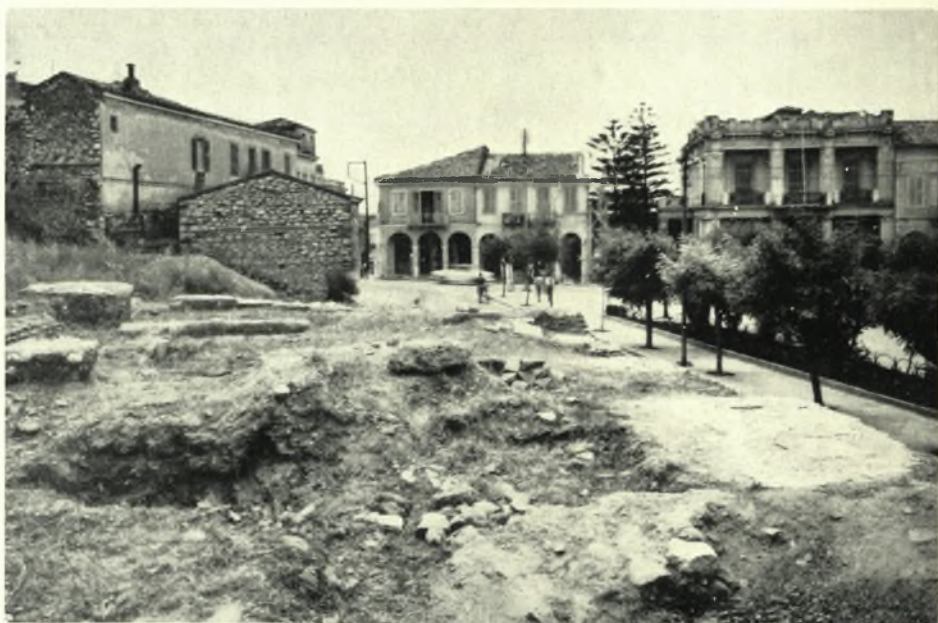
Ἄχαϊα: α. Ὁ βυζαντινὸς ναὸς τοῦ Ἁγίου Δημητρίου Μπάδα μετὰ τὰς ἐργασίας στερεώσεως, β. Ἐρείπια τοῦ ναοῦ τοῦ Ἁγίου Γεωργίου Πατρῶν
