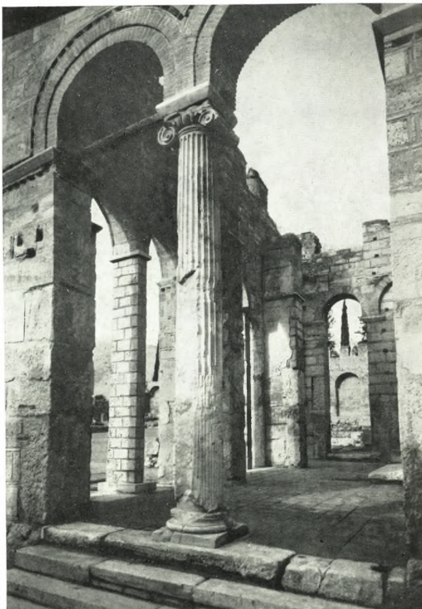
Όψις από Νότου τοῦ ἐσωτερικοῦ τοῦ ἐξωνάρθηκος τοῦ καθολικοῦ τῆς Μ. Δαφνίου μετὰ τὰς ἐργασίας ἀποκαταστάσεως αὐτοῦ.
