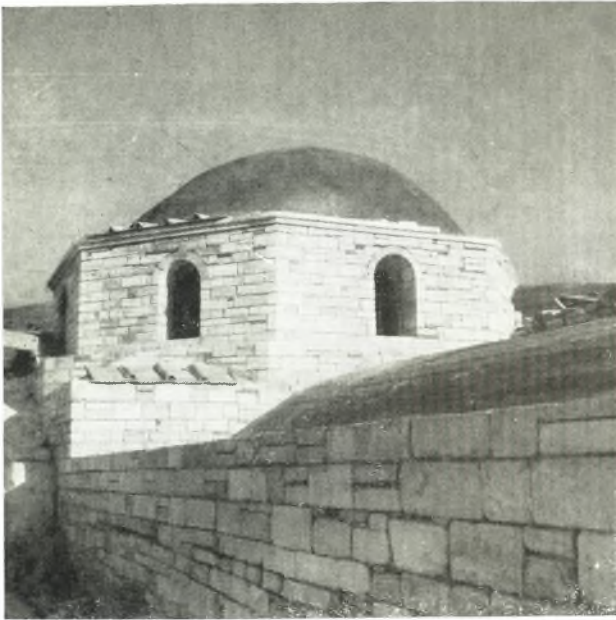
α. Ὁ ἀποκατασταθεὶς τροῦλλος τοῦ ναοῦ τῆς Καταπολιανῆς.
