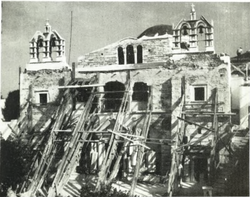
β. 'Η πρόσοψις του ναού της Καταπολιανής κατά την διάρκειαν των έργων αναπαλαιώσεως αυτής.
