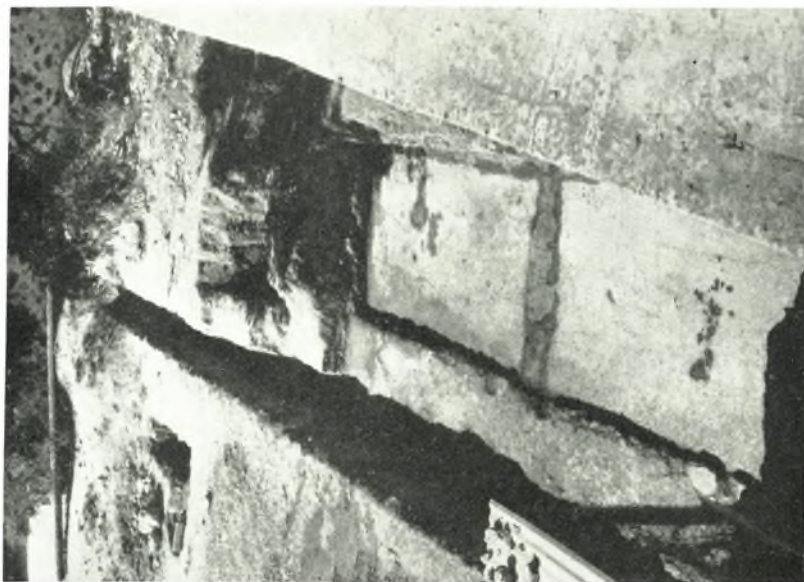
α. Τὸ δομᾶτιον Ε ἀπὸ Α. καὶ ὁ διάδρομος Λ.
