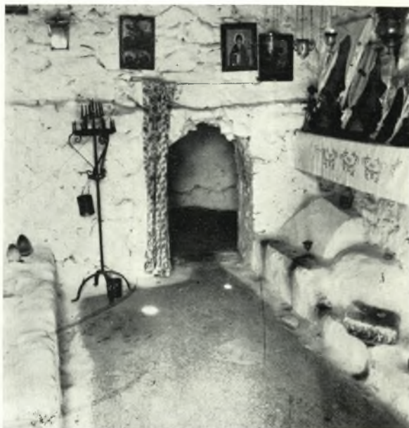
α. Ἡ σημερινή μορφή τοῦ παρεκκλησίου τῆς Ζωοδόχου Πηγῆς μέ τὸ ἀρχικὸν ψηφιδωτὸν δάπεδον. Εἰς τὸ βάθος (βορεια πλευρά) χαμηλὴ εἴσοδος εἰς τὸν ἀψιδωτὸν χώρον Α.
