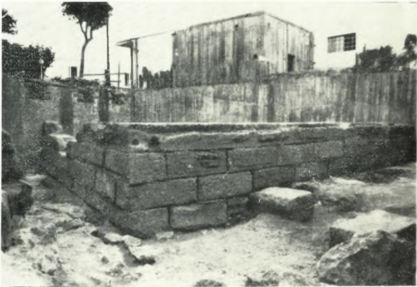
β. Οίκ. Παπαχριστοδούλου. 'Ο βόρειος τοῖχος τῆς ὁδοῦ Ρ3β. Λήψεις ἀπὸ Ν.
