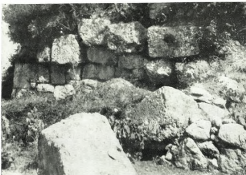
α. Ἀναλημματικός τοῖχος ἀνδῆρου ἐν Σάμῃ.
