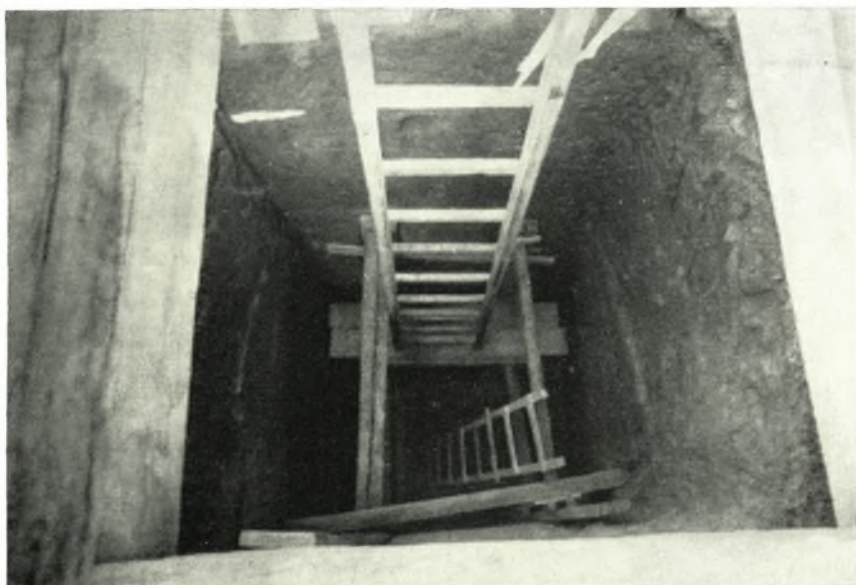
β. Τὸ φρέαρ ἑνὸς τῶν πεδίων θεμελιώσεως τῆς Δυτικῆς πλευρᾶς τοῦ στεγάστρου Β.
