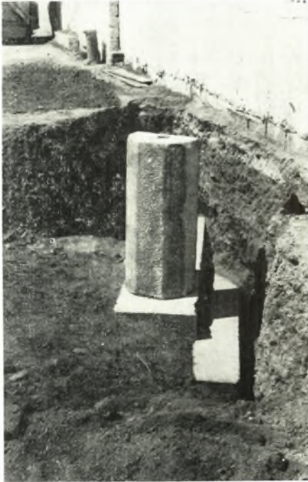
α. Ὁ σπόνδυλος τοῦ κίονος μετὰ τὴν τοποθέτησίν του ἐπὶ τοῦ στυλοβάτου.
