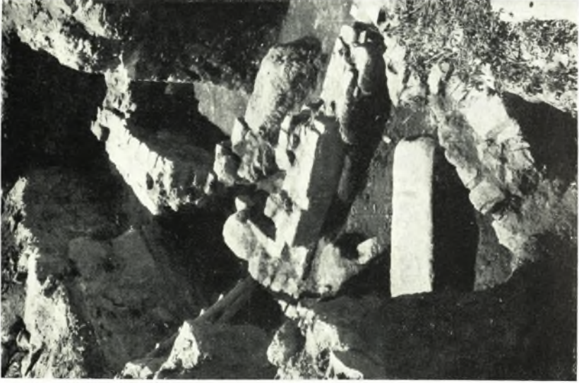
β. Τὰ κτίσματα ἀνατολικῶς τοῦ σημείου συναρτήσεως τῶν στῶν.
