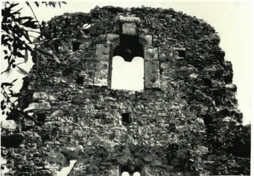
β. "Αγιος Λέων Μεθώνης. Ἐξωτερικὴ ὄψις τοῦ νοτίου τυμπάνου τῆς ἐγκαρσίας καμάρας. Χαμηλά, διὰ μέσου ἀκανονίστου ἀνοίγματος, φαίνεται τὸ βόρειον τύμπανον.
