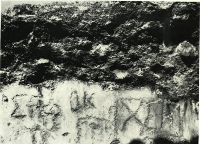
β. Ὑπέργειος δεξαμενή εἰς Λυκοτόμαρον Μεθώνης. Λεπτομέρεια τῆς ἐσωτερικῆς ἐπιφανείας.
