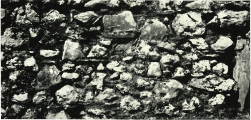
α. Ὑπέργειος δεξαμενὴ εἰς Λυκοτόμαρον Μεθώνης. Τοιχοδομία τῆς ἀνατολικῆς ὀψείας (λεπτομέρεια).
