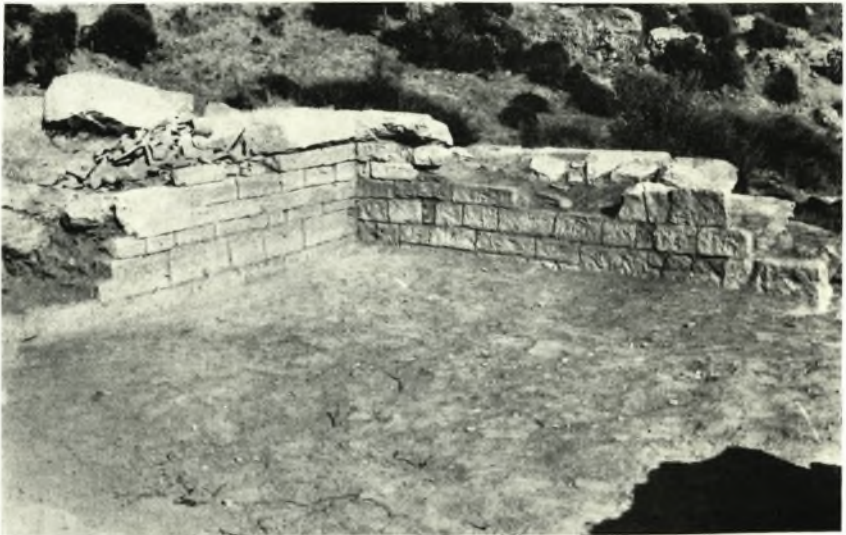
β. Ἐσωτερικὴ ΒΑ. γωνία τοῦ Πύργου «Φυλακές».
