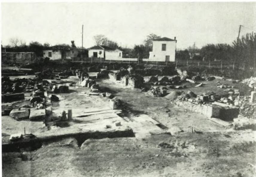
α. Οι δύο νάρθηκες και τὸ αἶθριον κατὰ τὴν ἀνασκαφήν (ἀπὸ Βορρᾶ).
