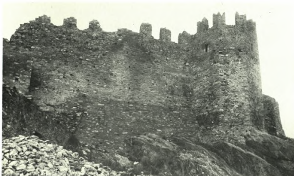
Εύβοια. Φρούριον Καρύστου : α. Πυλών. Ἡ ἔσω πύλη μετὰ τὰς ἐργασίας, β. Τμήμα τοῦ παρὰ τὸν πυλῶνα τείχους μετὰ τὰς ἐργασίας
