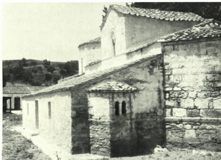
Εύβοια : α. Λούτσα. Ναός Ἁγίας Παρασκευῆς, β - γ. Ὁ ναός Ἁγίου Δημητρίου Αὔλωναρίου πρὸ και μετὰ τὰς ἐργασίας
