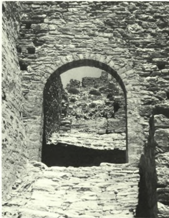
Εύβοια. Φρούριον Καρύστου: α. Ἡ θύρα τοῦ προτειχίσματος μετὰ τὰς ἐργασίας, β. Πυλών. Ἡ ἐξω πύλη μετὰ τὰς ἐργασίας
