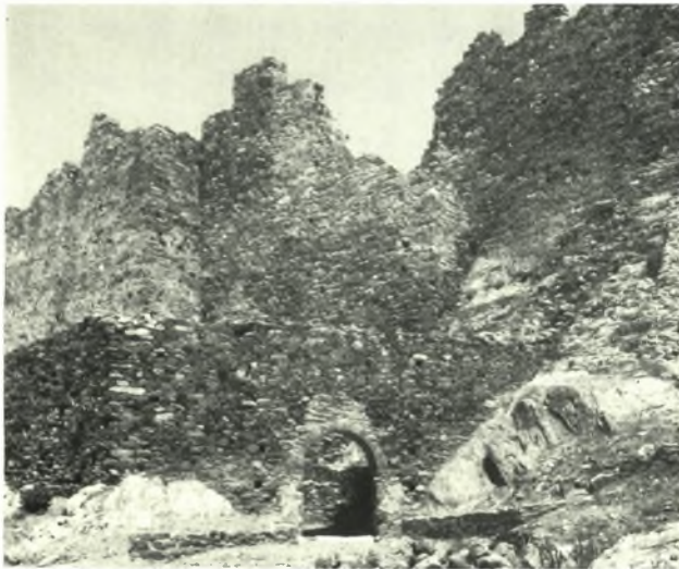
Εύβοια : α. 'Αγία Θέκλα. 'Ο ναός 'Αγίας Θέκλης μετά τας έργασίας, β. Φρούριον Καρύστου. 'Η πρὸς τὴν πόλιν πλευρά, γ. Φρούριον Καρύστου. Τὸ προτείχισμα καὶ ὁ πυλὼν μετά τας έργασίας
