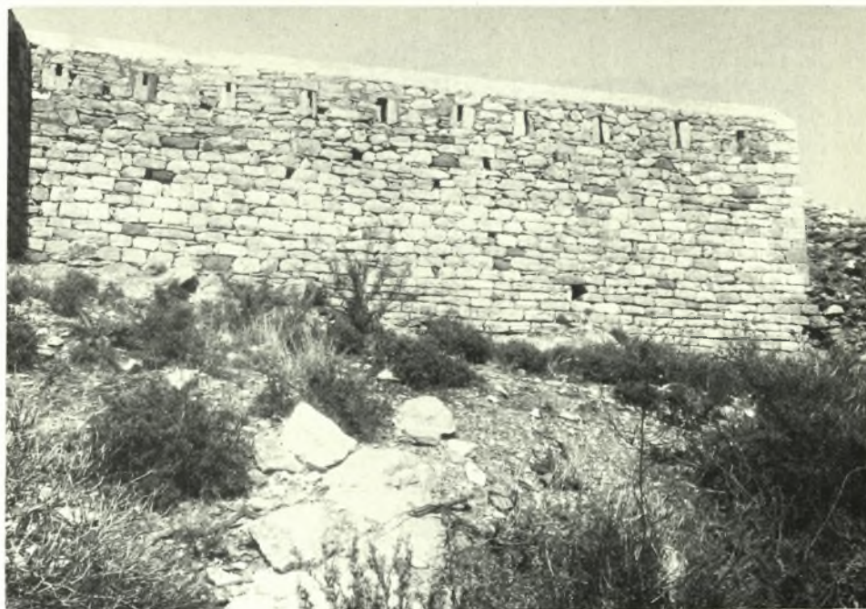
Ἄττική. Πόρος. Μπουρτζι: α. Πύργος εἰς τὴν ΝΔ. γωνίαν μετὰ τὰς ἐργασίας, β. Τὸ Ν. τείχος μετὰ τὰς ἐργασίας
