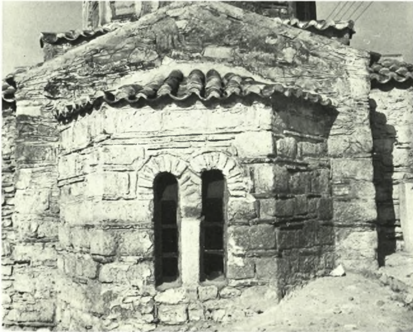
Ἄττική. Συκάμινον : α. Ναός Κοιμήσεως τῆς Θεοτόκου. Ἡ Πλατυτέρα, β. Ναός τῶν Ἁγίων Τεσσαράκοντα. Τὸ ἱερόν μετὰ τὰς ἐργασίας
