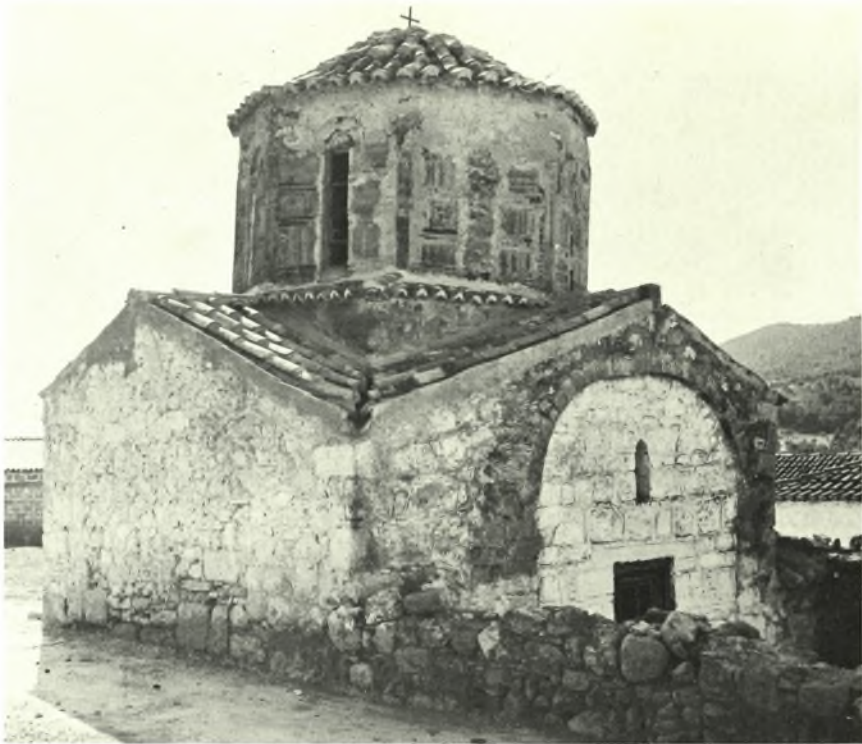
Ἀττική. Συκάμινον: α - β. Ὁ ναὸς τῶν Ἁγίων Τεσσαράκοντα ἀπὸ ΒΔ., πρὸ καὶ μετὰ τὰς ἐργασίας
