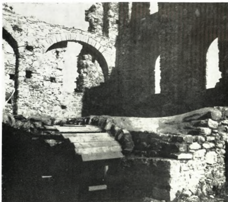
β. Κτίριον Β. πύλης εἰσόδου Μοναστηρίου, κατὰ τὰς ἐργασίας συμπληρώσεως τῶν σταυροθολίων.
