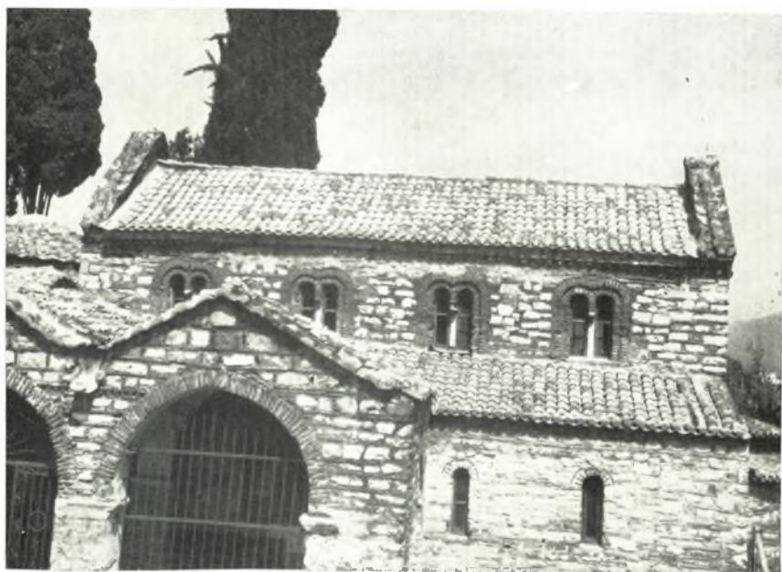
β. Ἡ νέα κατασκευασθεῖσα στέγη τῆς Ἁγ. Θεοδώρου.
