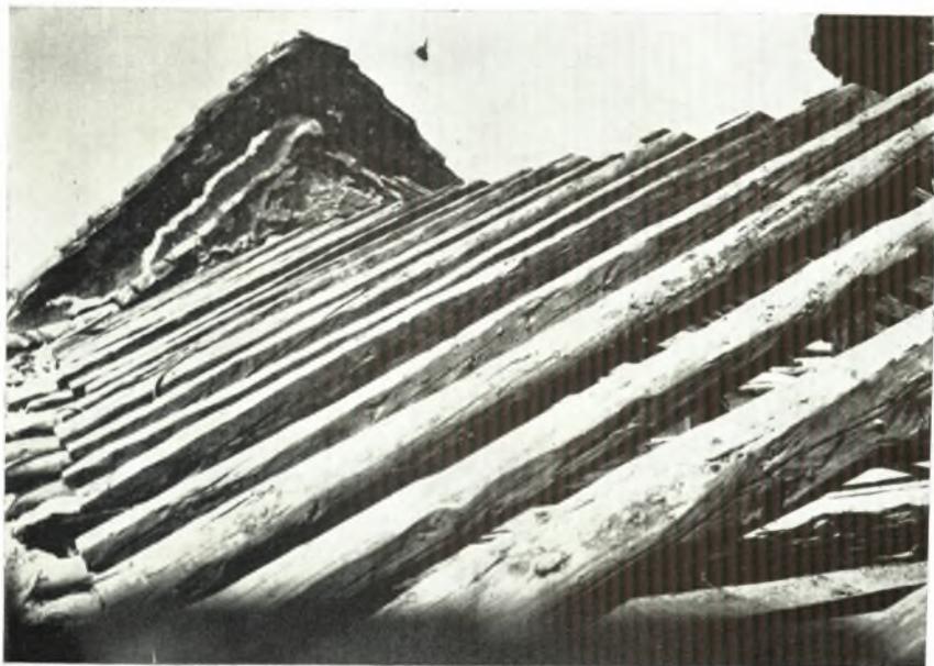
α. Ἡ παλαιὰ στέγη τῆς Ἁγ. Θεοδώρου μετὰ τὴν ἀφαίρεσιν τῶν κεραμῶν. Εἰς τὸ βάθος φαίνονται ὀπίσθεν τοῦ ἀετώματος τὰ ἴχνη τῆς ἀρχαίας στέγης.
