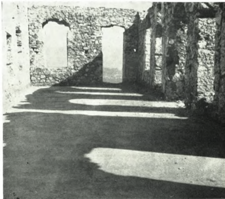
β. Σπίτι Φραγκοπούλου μετὰ τὰς ἐργασίας.
