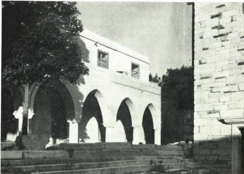
β. Αἱ ἀποκατασταθεῖσαι δύο ἀνατολικαὶ πλευραὶ τῆς βορείου πλευρᾶς τῆς αὐλῆς.
