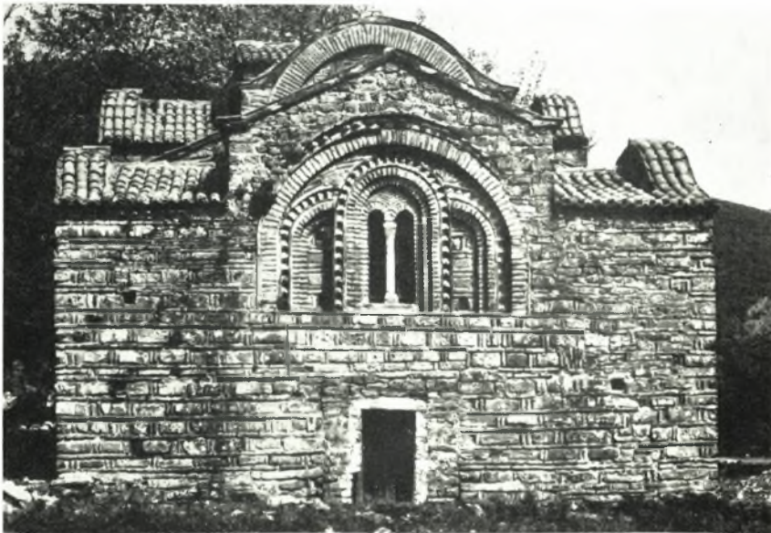
β. Ἡ πρόσοψις τῆς Κόκκινης Ἐκκλησίας μετὰ τὸ ἀρμολόγημα αὐτῆς.
