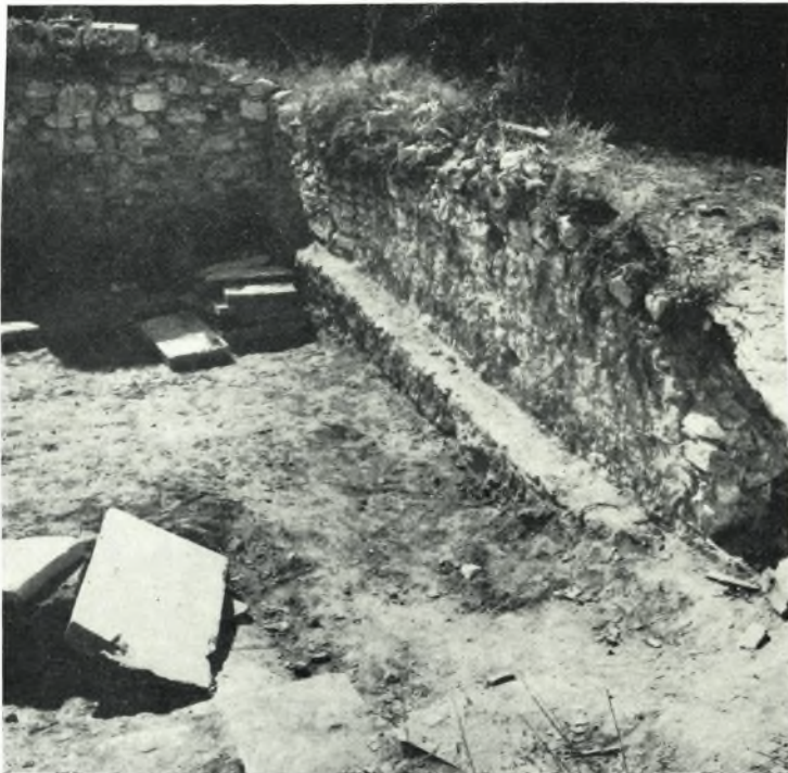
β. Ἀποψις τῆς ΝΑ. γωνίας τοῦ ναοῦ μετὰ τὰς ἐργασίας τοῦ 1967.
