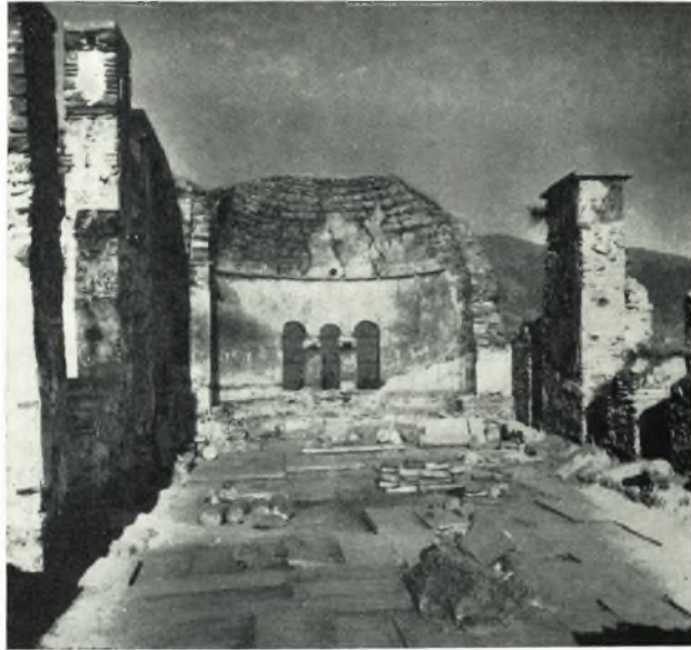
α. Ὁ ἐσωτερικὸς χώρος τῆς βασιλικῆς μετὰ τὴν ἀνασκαφὴν.
