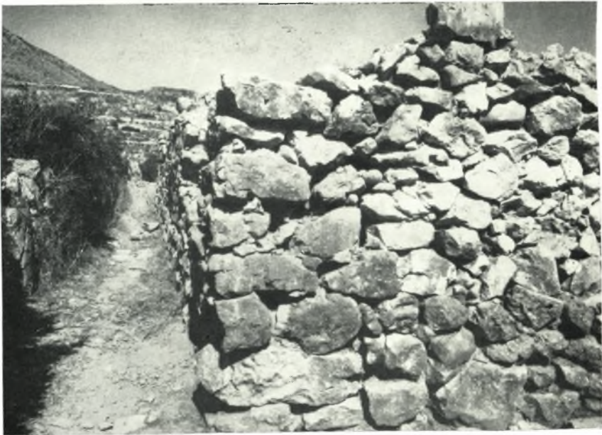
β. Βορειοδυτικὴ γωνία τοῦ κτηρίου Γ.
