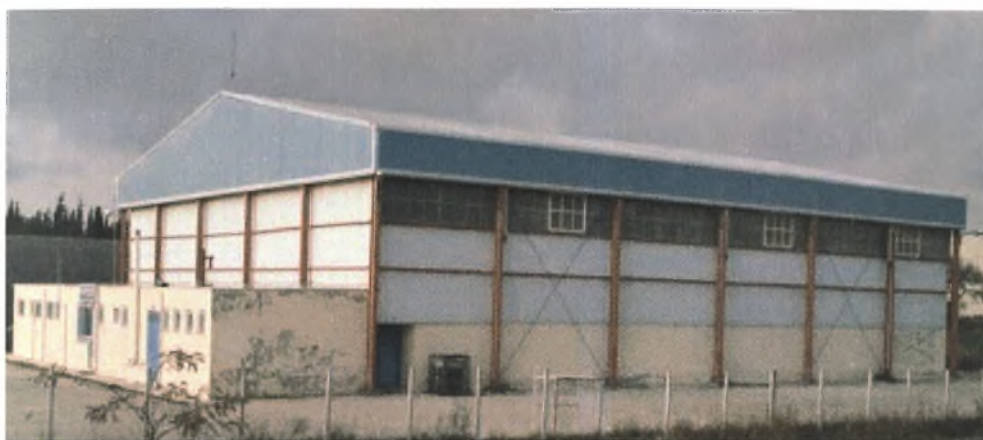
Εικ. 65. Προπονητήριο (εξωτερικά)
