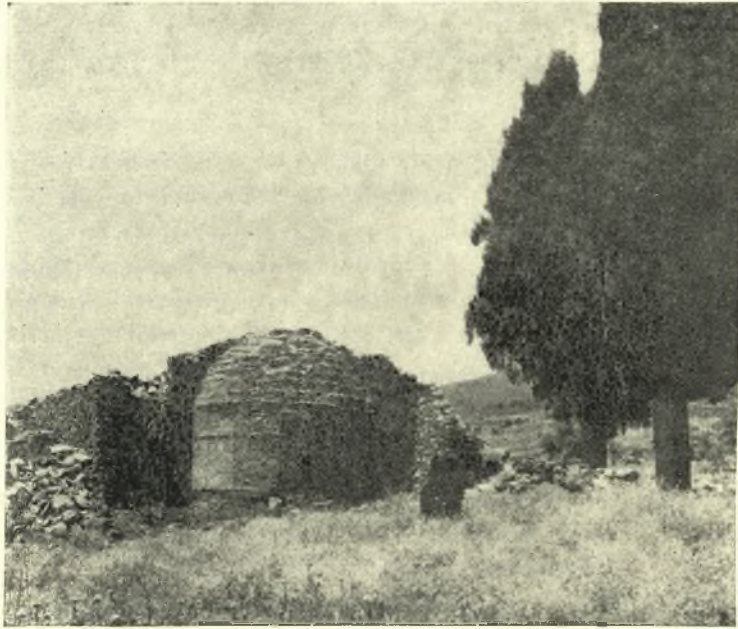
Εἰκ. 6. Ἐσῶθαι τοῦ ἡρειπωμένου ναοῦ τοῦ ἁγίου Νικολάου Βαθυρρεῖματος.
