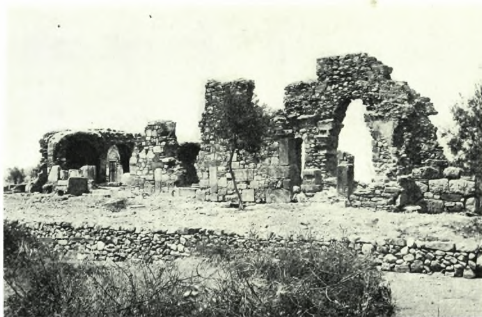
Τροιζήν-Δαμαλάς. Τὰ ἑρείπια τῆς Ἐπισκοπῆς: α. πρὸ τοῦ καθαρισμοῦ, β. μετὰ τὸν καθαρισμὸν
